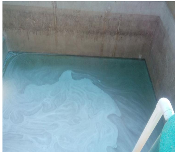
污水站调节池
