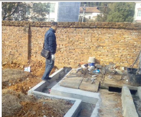
生活废水排放口
