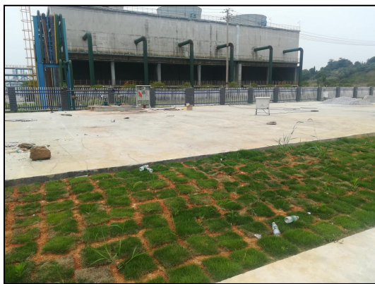
地下污水收集池、事故池、初期雨水池
