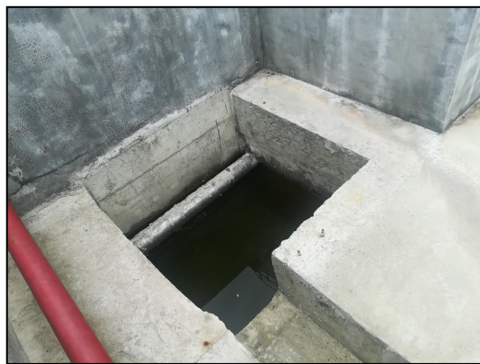
罐区围堰内废水导流沟
