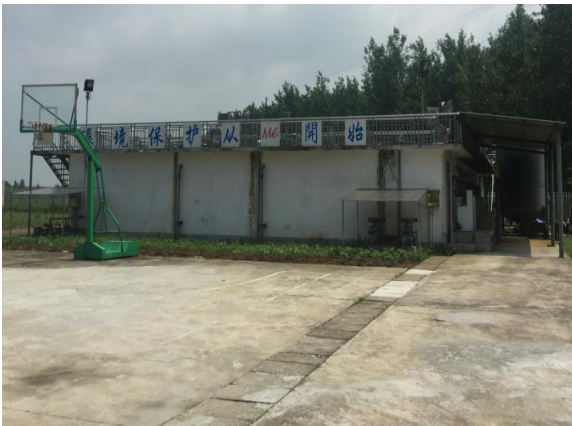
污水处理站全貌
