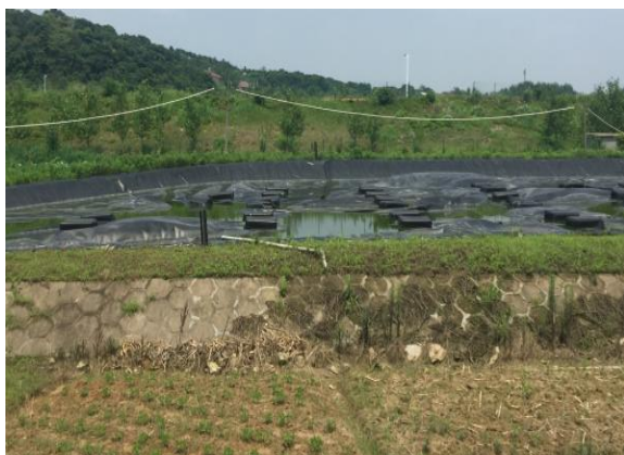
渗滤液调节池
