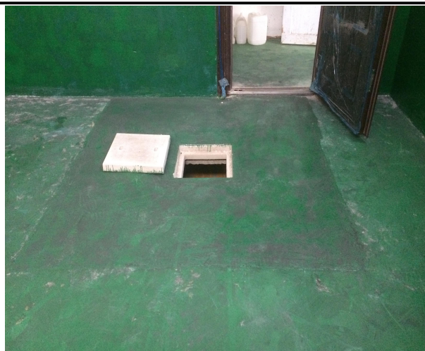
硫酸库房下房应急池
