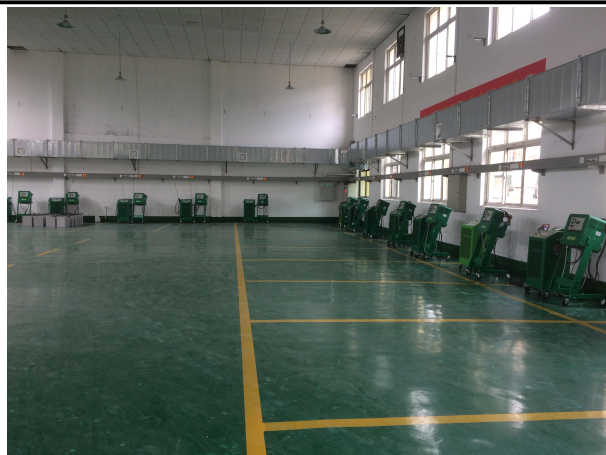
防渗环氧树脂地面（已做墙面防腐）
