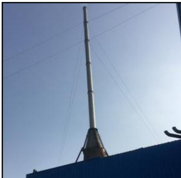
锅炉房排气筒（45m）
