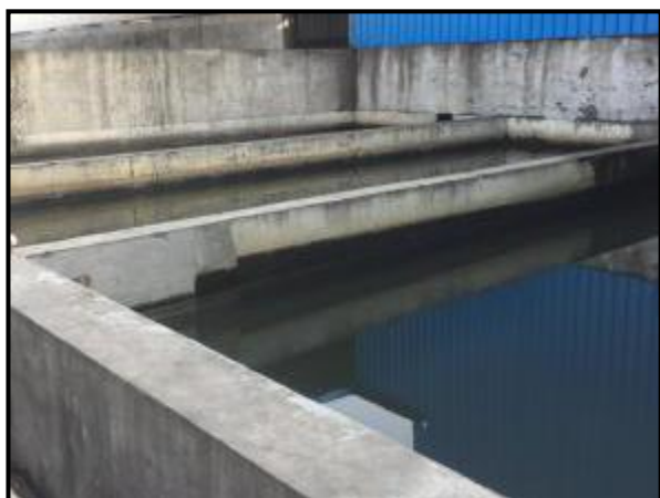
除尘废水循环池
