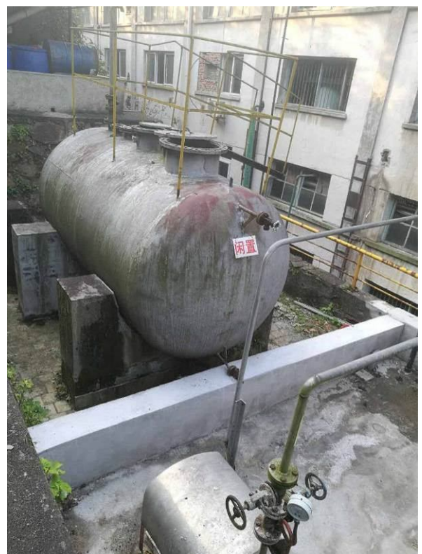
闲置罐区（挂牌）
