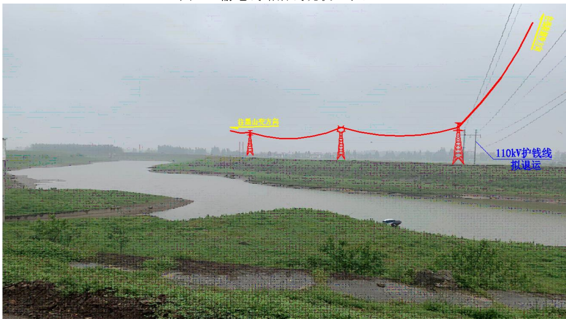
图 3-4 输电线路沿线现状（跨越华容河）
