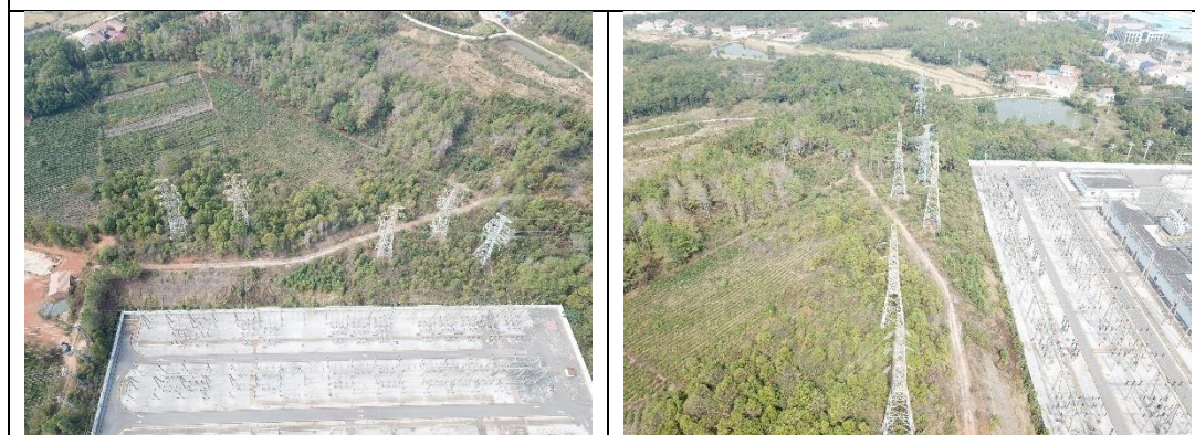
文里 220kV 变电站 110kV 间隔侧厂界
