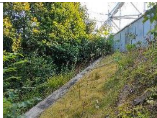
图冲 220kV 变电站出线侧现状照片
