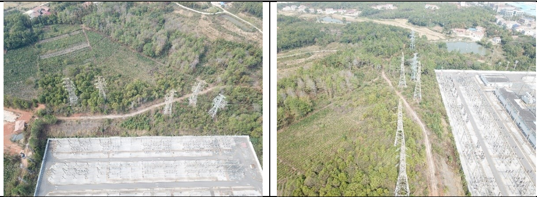
文里 220kV 变电站 110kV 间隔侧厂界
