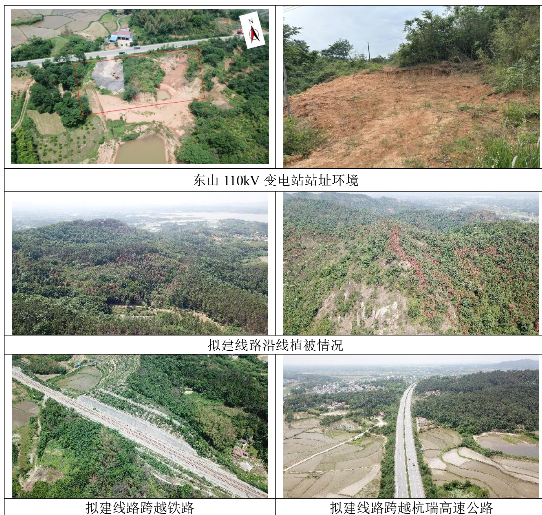
图 3 湖南岳阳华容县东山 110kV 输变电工程环境现状
