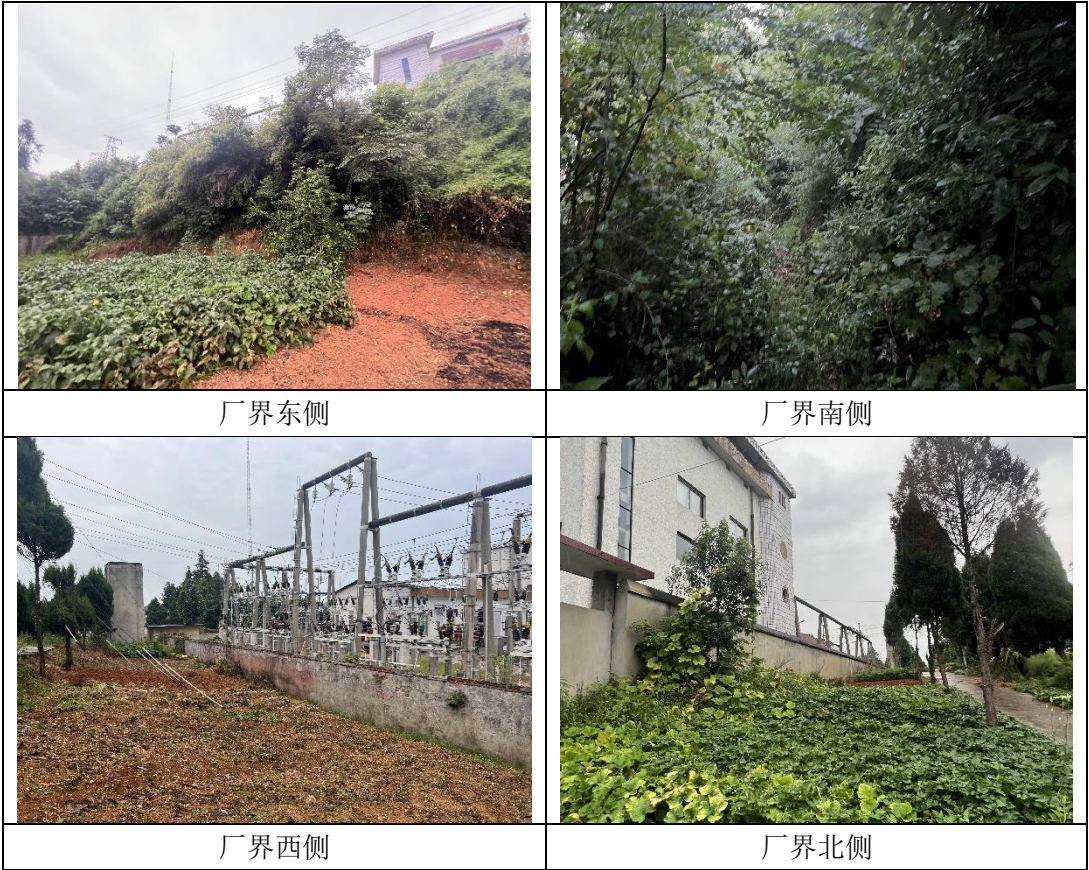
图 6 源潭 110kV 变电站区域自然环境现状
