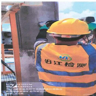
DA003 碳化罐排放口 2
