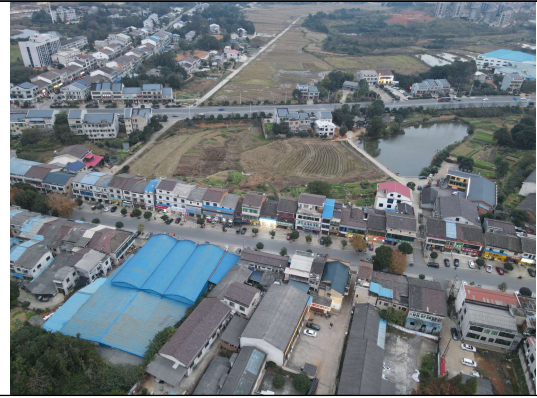
拟建线路跨越 S102 省道
