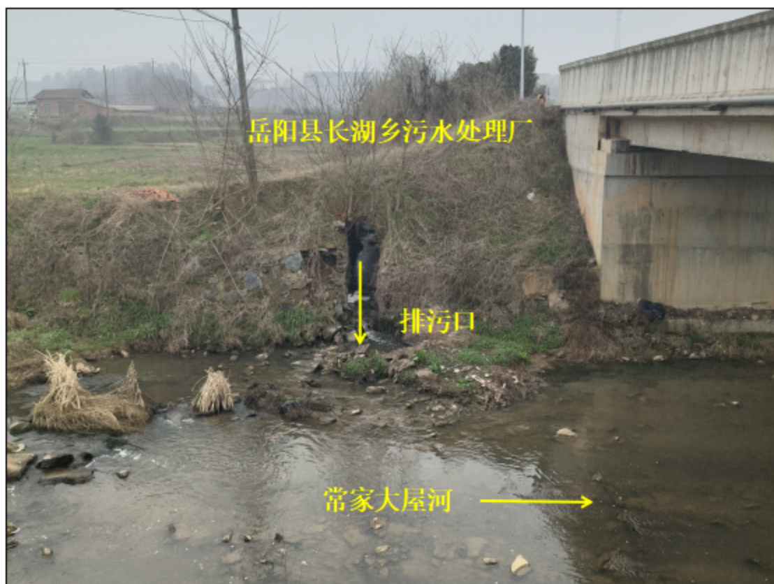
图 3.3-1 长湖乡污水厂排污口现状图
