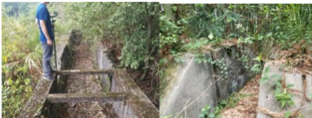
图3.3-15 渡槽混凝土老化、鼓起、剥落
