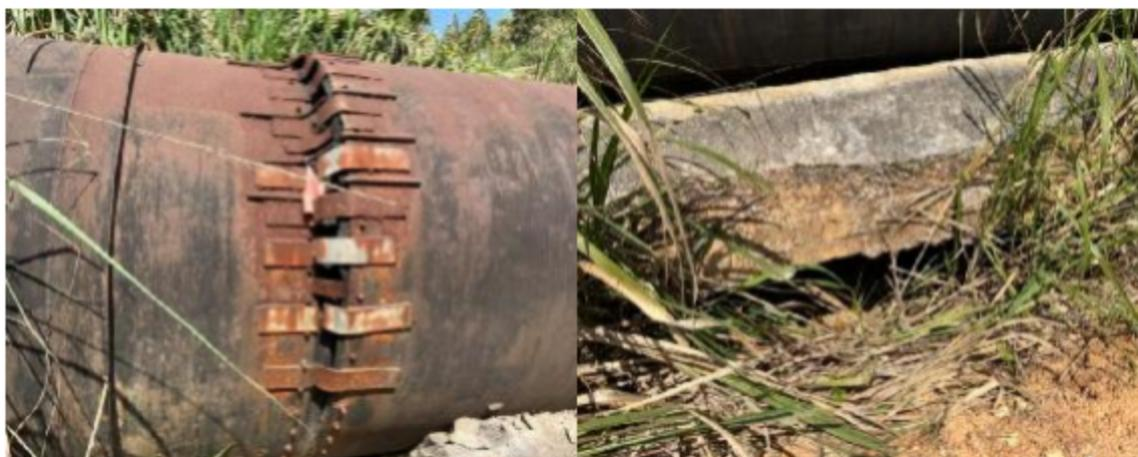
图3.3-7 现状涵管错位破损基础冲刷掏空
