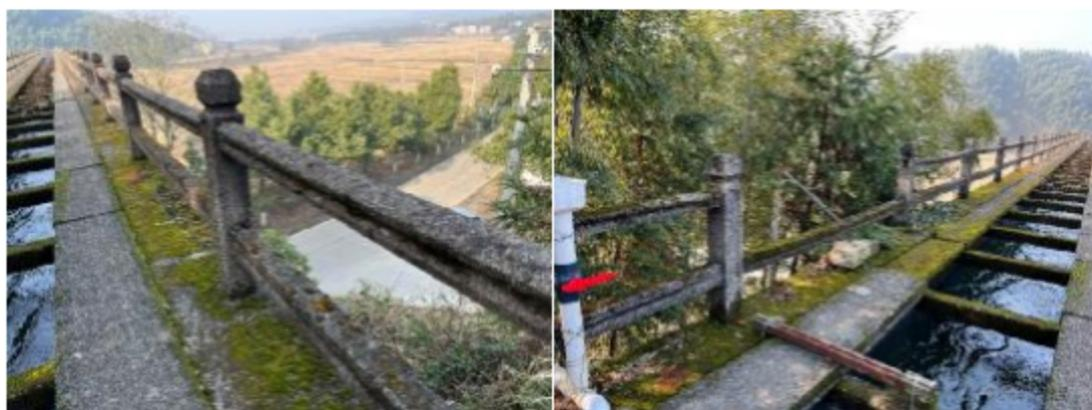
图3.3-18 栏杆混凝土老化、局部破坏
