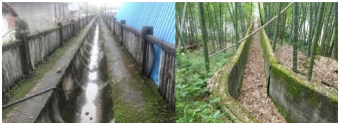
图3.3-14 渡槽止水渗水严重、渡槽侧壁裂隙
