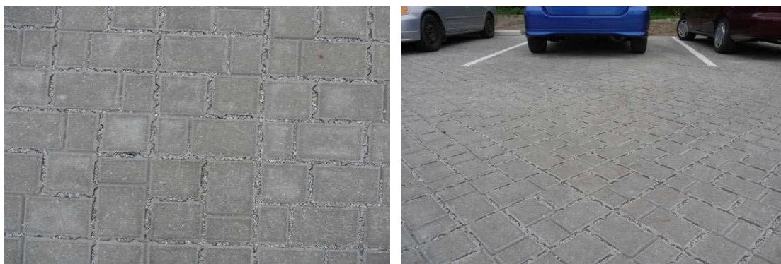
图 9-35 透水铺装实物图
