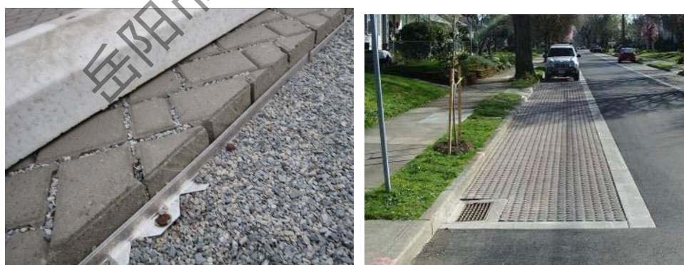
图 9-39 金属和混凝土结构透水铺装边缘
