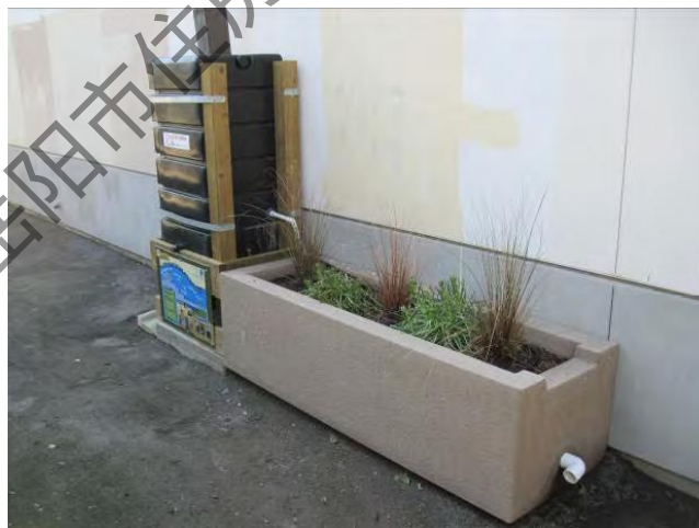
图 9-50 蓄水池的出口连接方式
