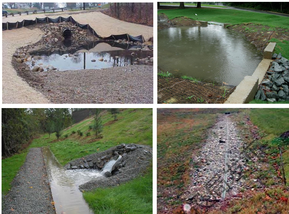
图 9-15 水平导流设施实物图
