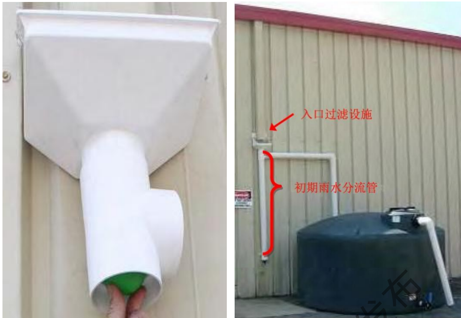
图 9-49 初期雨水分流设施（左图为安全阀，右图为初期雨水分流管）
