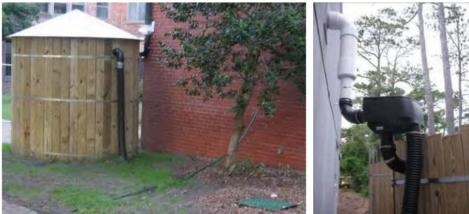
图 9-51 蓄水池溢流装置（左图为溢流管，右图为分放管）
