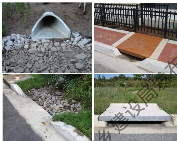
图 9-5 常见的雨水入口设计
