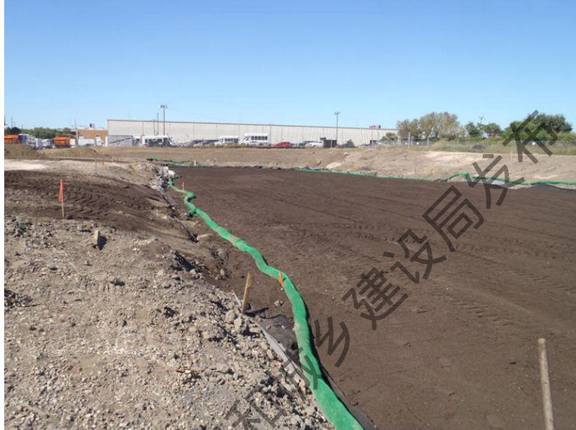
图 9-28 湿塘施工现场图
