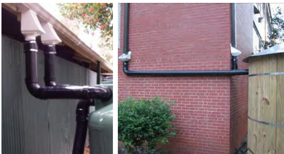
图 9-48 入口过滤设施安装方式（左侧为与屋顶排水沟连接，右侧为断接管末端）
