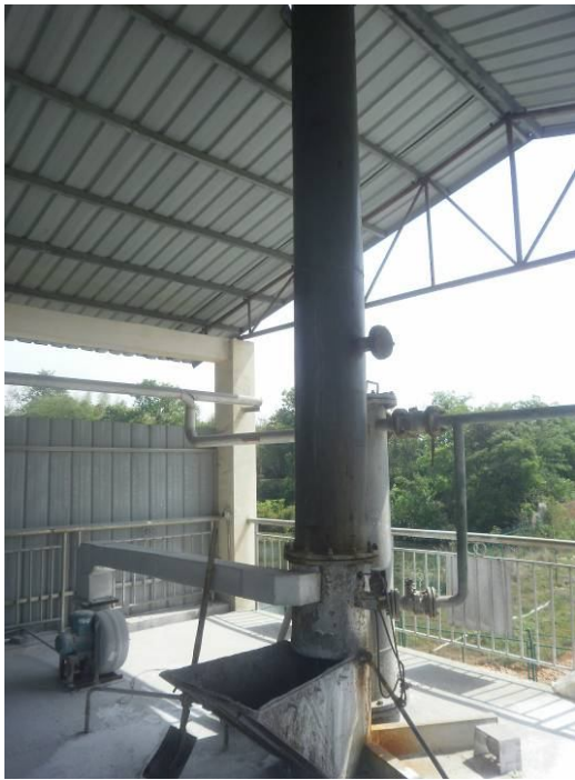
图 3-8 废气排放装置
