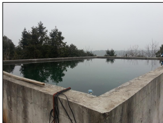
中水回收池俯拍
