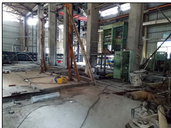
浮选车间设备拆除后现场
