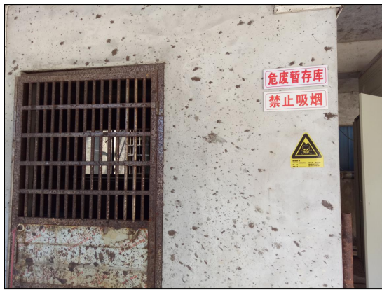
危险废物暂存处
