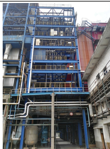
4#锅炉 SCR 脱硝系统
