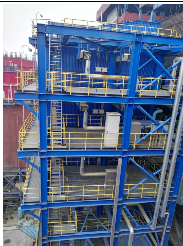
3#锅炉 SCR 脱硝系统
