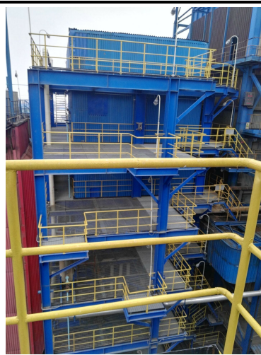
2#锅炉 SCR 脱硝系统
