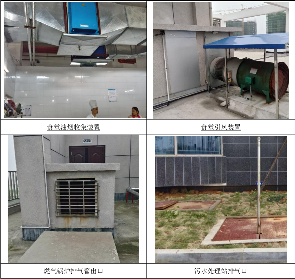
图 3-5 现场废气收集系统、排气管、净化装置图
