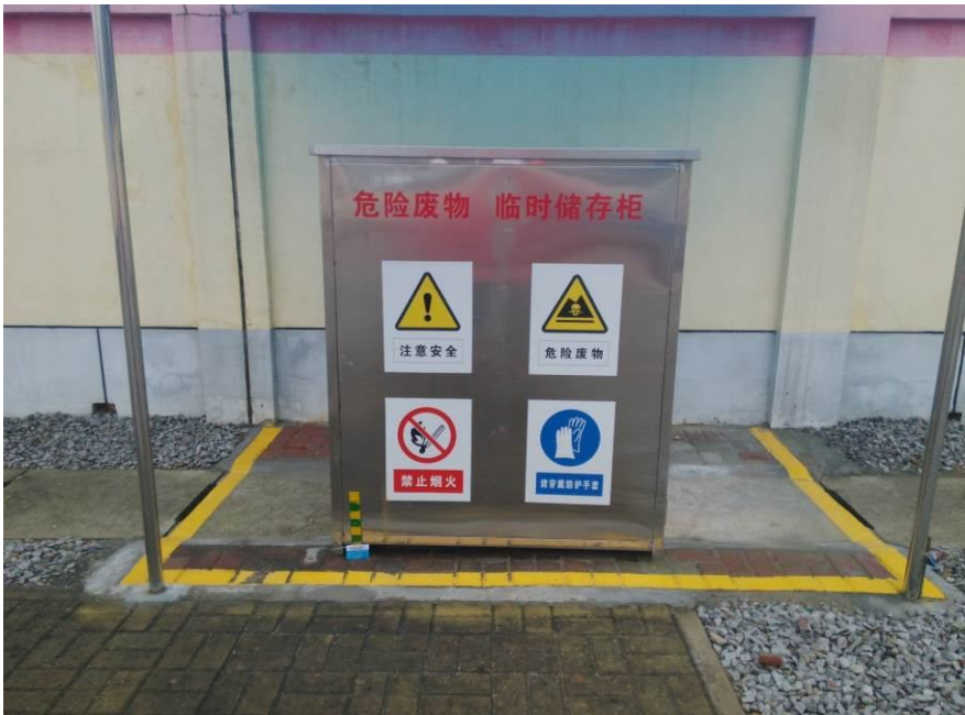
图 3-11 危险固废临时暂存柜示意图
