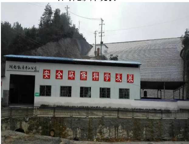
石坪尾矿库坝下废水处理站
