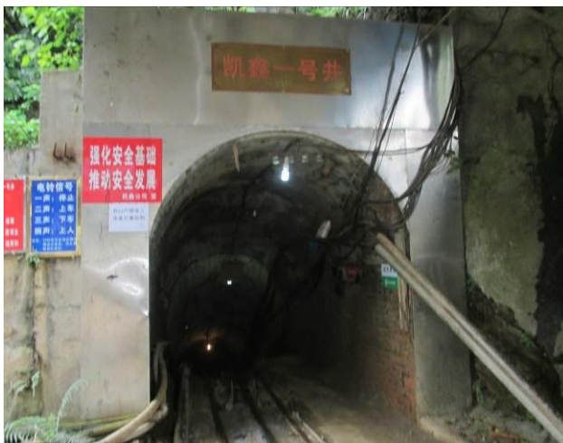
采矿工业广场主斜井
