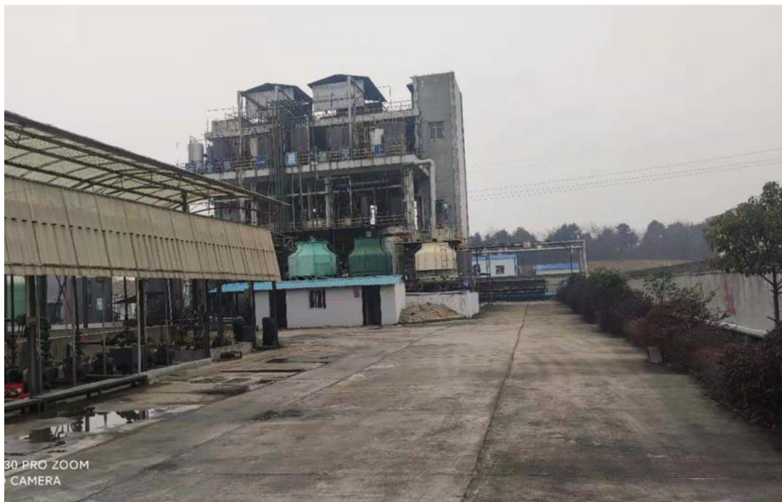
图 5.3-4 项目场地硬化及绿化带现状照片
