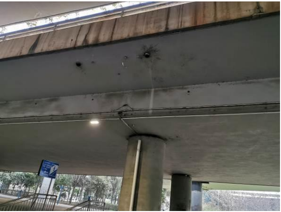
图3.1.1-20 10#墩处左侧泄水管损坏
