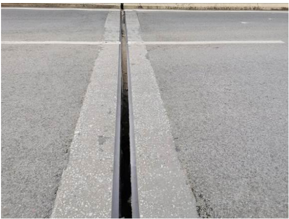
图3.1.3-16 5#伸缩缝止水带破损，结构缝宽异常，伸缩缝宽度 7.6cm
