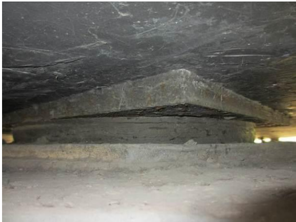
图3.1.13-4 1#支座开裂、钢板锈蚀
