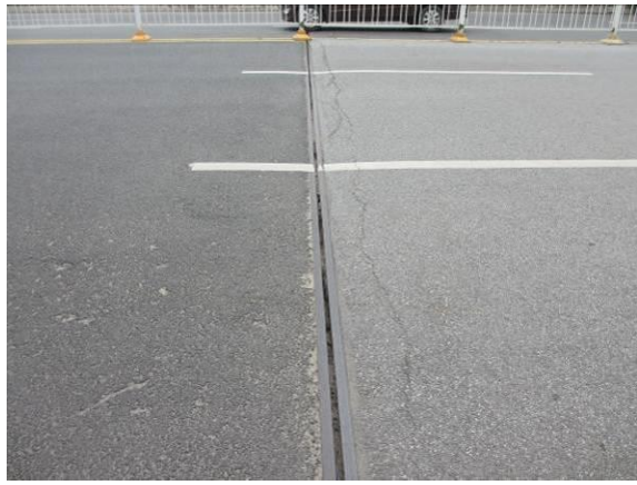
图3.2.2-8 Y-3#伸缩缝止水带破损，伸缩缝宽度 1.4cm
