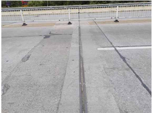
图 3.1.1-10 0#伸缩缝堵塞, 伸缩缝宽 3.1cm
