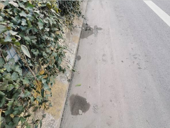
图3.1.3-20 桥面较多泄水孔堵塞
