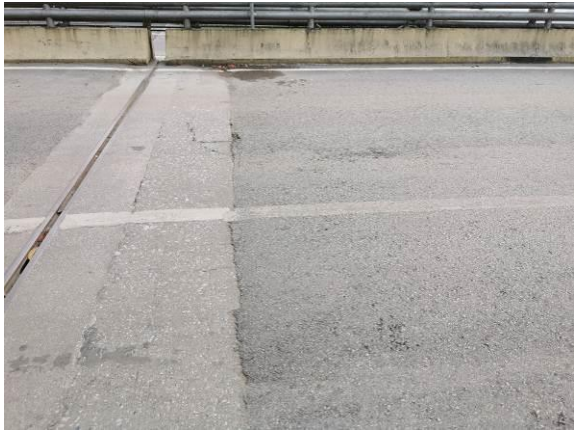
图3.1.8-10 1#桥面铺装局部坑槽，面积约 0.05 m²
