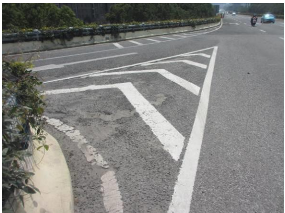
图3.1.5-33 14#桥面铺装局部坑槽，面积约 2.0 m 2
