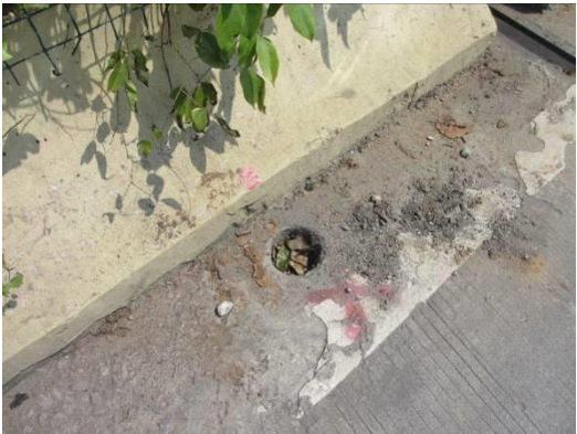
图3.1.10-8 桥面较多泄水孔堵塞
