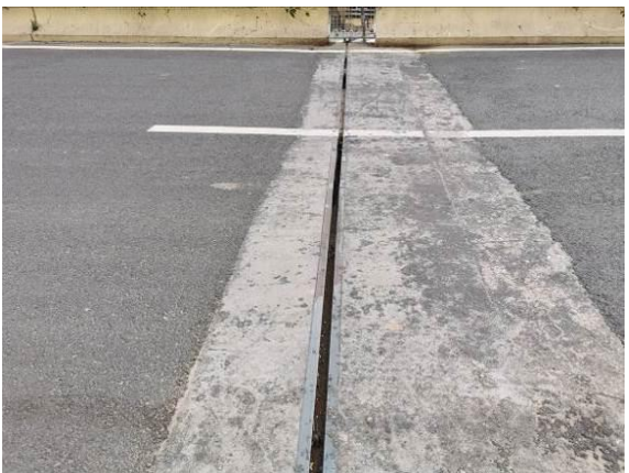
图 3.1.2-16 17#伸缩缝止水带破损，伸缩缝宽度 3.2cm
