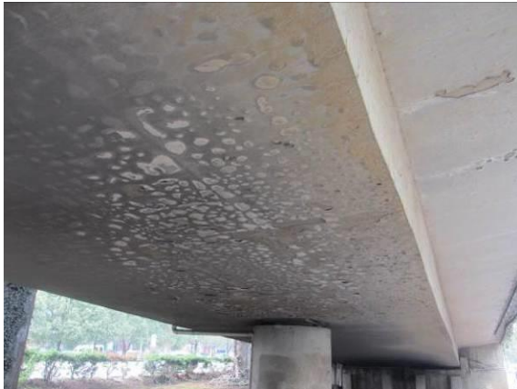
图3.1.11-14 28#跨梁体涂层脱落，面积约 18 \text{ m}^2
