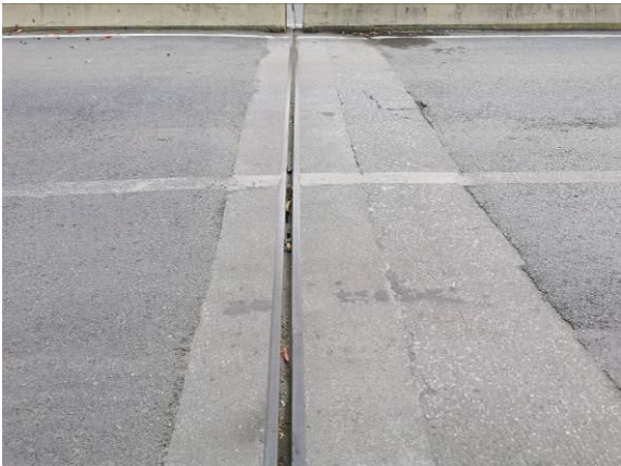
图 3.1.8-11 0#伸缩缝堵塞、止水带破损，伸缩缝宽度 4.0cm
