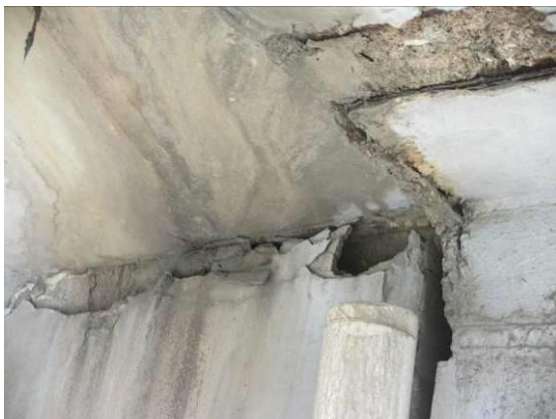
图3.1.11-6 22#跨梁体 21#墩处左侧腹板破损，面积 1.65 \times 0.85 \text{ m}^2 ，钢筋锈蚀
