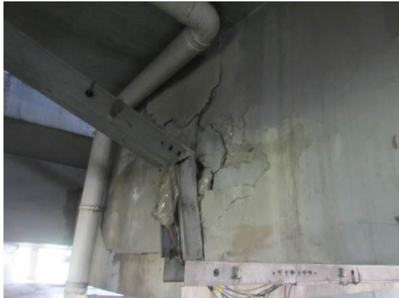
图 3.1.14-5 1#跨梁体伸缩缝处右侧腹板破损，面积约 0.9 m²
