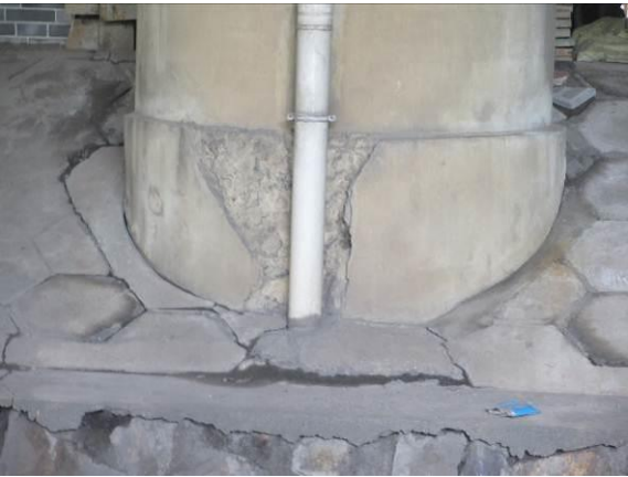
图 3.1.1-4 5-1#立柱左侧下部局部破损,面积约 0.2 m²
