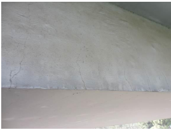
图3.1.11-11 22#跨梁体腹板竖向裂缝，缝宽 0.18\text{mm}
