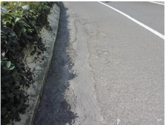
图 3.1.7-14 9#桥面铺装局部坑槽，面积约 2.3 m²
