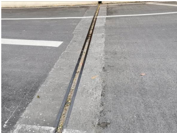
图3.1.13-5 0#伸缩缝堵塞，结构缝宽异常，伸缩缝宽度 6.0cm
