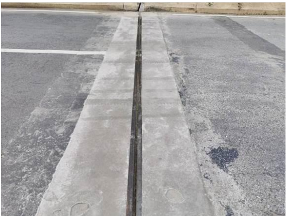
图3.1.3-18 17#伸缩缝堵塞，伸缩缝宽度 3.0cm
