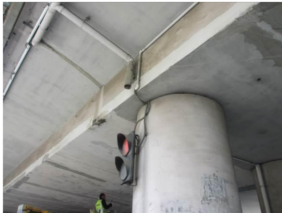
图 3.1.4-21 4#墩处泄水管破损
