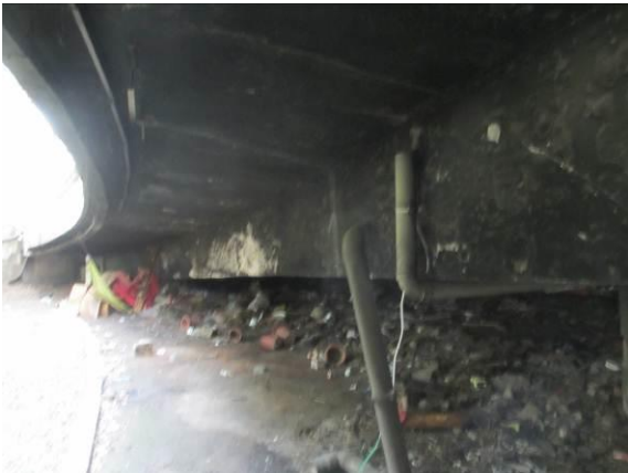
图 3.1.8-14 1#墩处泄水管破损
