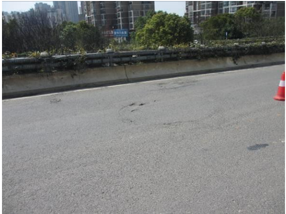
图3.1.11-19 23#桥面铺装局部坑槽，面积约 1.0 m²
