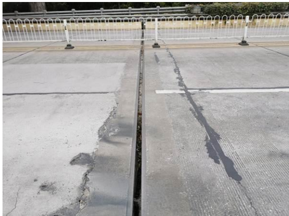
图3.1.1-12 8#伸缩缝止水带破损，结构缝宽异常伸缩缝宽 6.8cm
