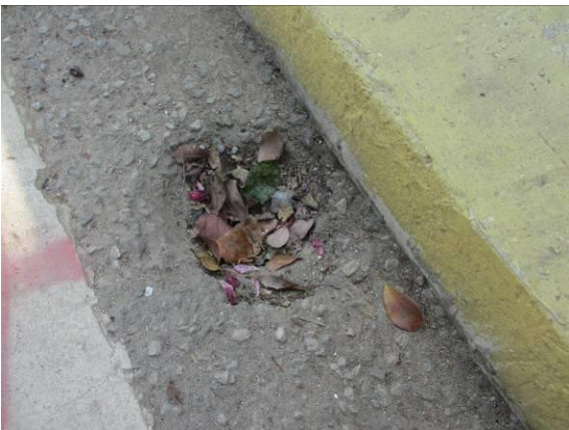
图3.1.4-19 桥面较多泄水孔堵塞
