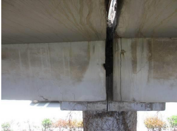
图 3.1.14-8 7#跨梁体 7#墩处右侧腹板破损开裂
