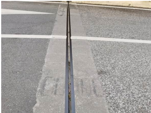
图 3.1.9-7 0#伸缩缝堵塞、止水带破损， 伸缩缝宽度 2.9cm
