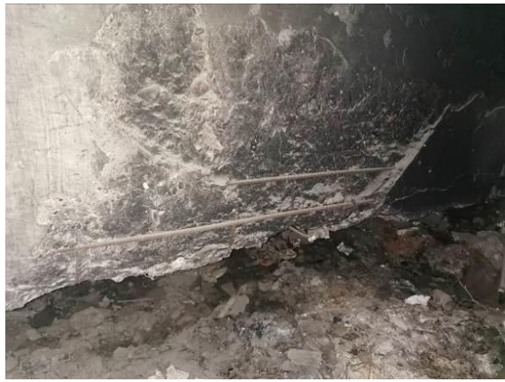
图3.1.8-6 1#跨3/4处左侧及底部混凝土破损、露筋、钢筋锈蚀，面积约 0.6 m²
