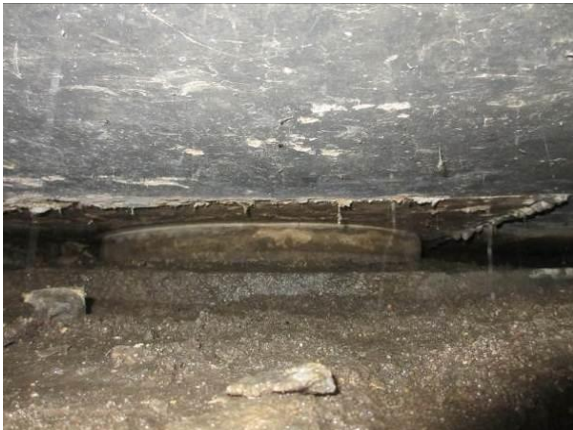
图 3.1.2-12 17-1#支座钢板锈蚀
