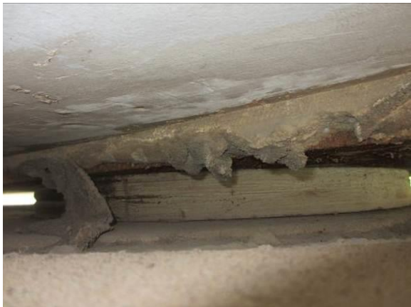
图3.1.11-17 22#支座开裂、钢板锈蚀
