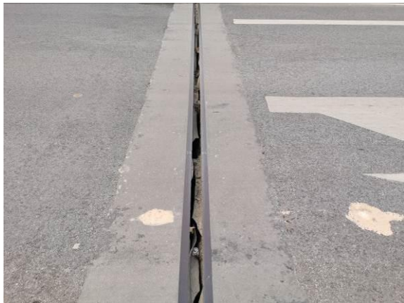
图3.1.3-17 8#伸缩缝止水带破损、破损，结构缝宽异常，伸缩缝宽度 6.3cm
