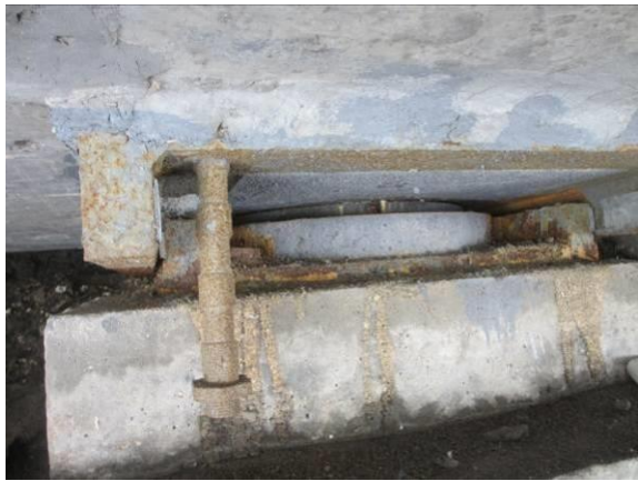
图 3.2.1-2 Z-3-1#支座钢垫板锈蚀
