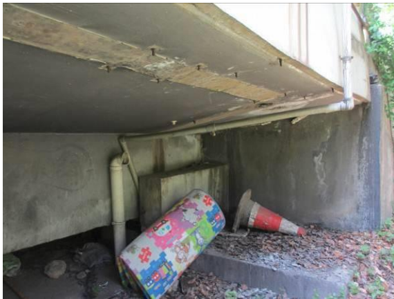
图 3.1.13-9 2#台处右侧泄水管破损
