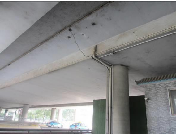
图3.1.1-17 6#墩处左侧泄水管损坏
