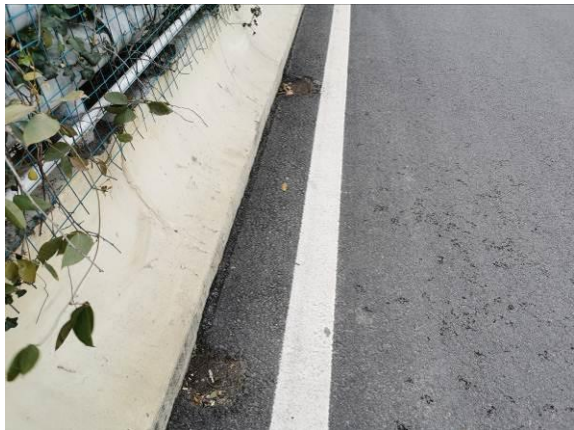
图 3.1.14-18 桥面较多泄水孔堵塞
