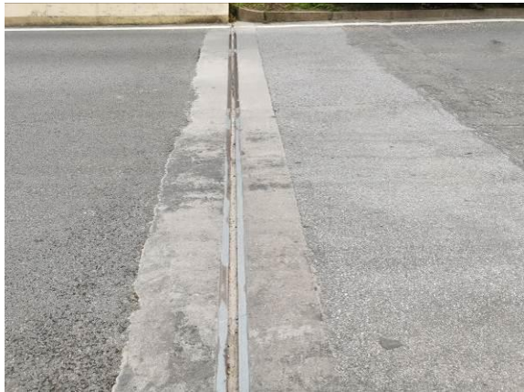
图 3.1.2-13 0#伸缩缝堵塞，伸缩缝宽度 3.4cm
