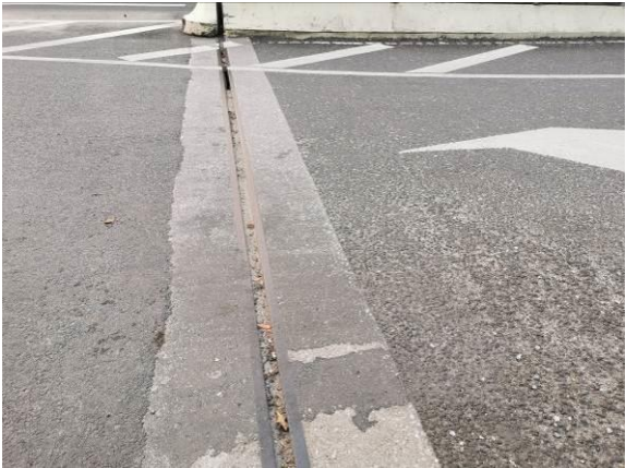
图3.1.16-8 3#伸缩缝堵塞、止水带破损，伸缩缝宽度 5.0cm
