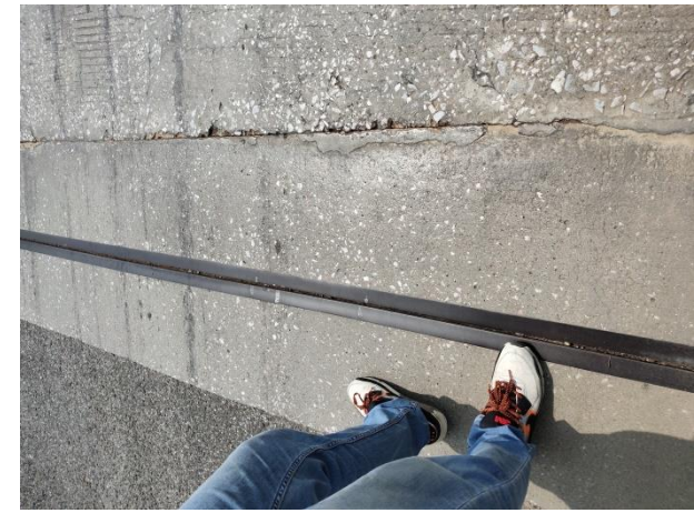
图 3.3.1-3 桥台处伸缩缝卡死
