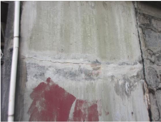
图 3.2.2-3 Y-3#桥台侧墙横向裂缝，距顶部 0.7m，L=0.6m，d=0.28mm
