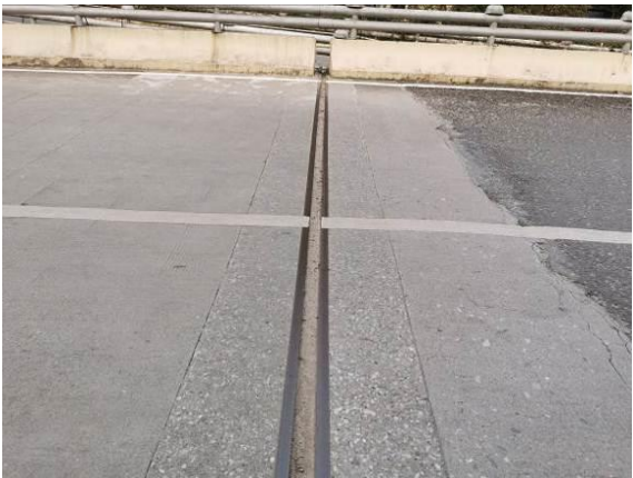
图3.1.16-7 0#伸缩缝堵塞，结构缝宽异常，伸缩缝宽度 6.8cm
