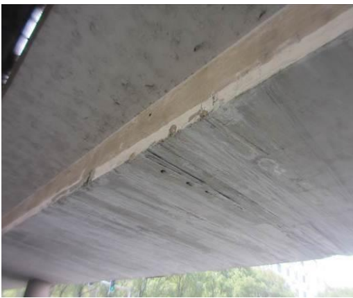
图 3.1.4-5 4#梁体右侧因车辆撞击破损
