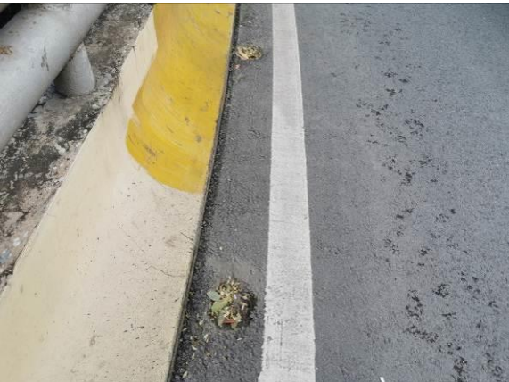
图 3.1.8-13 桥面较多泄水孔堵塞
