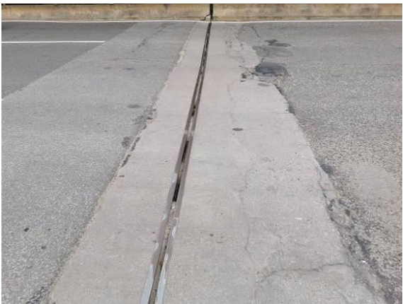
图3.1.4-16 10#伸缩缝堵塞、止水带破损，伸缩缝宽度 3.2cm，伸缩缝与路面连接处有高差
