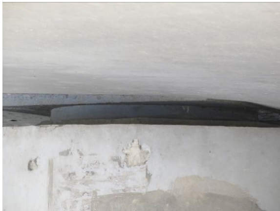
图3.1.11-18 28#支座开裂、钢板锈蚀
