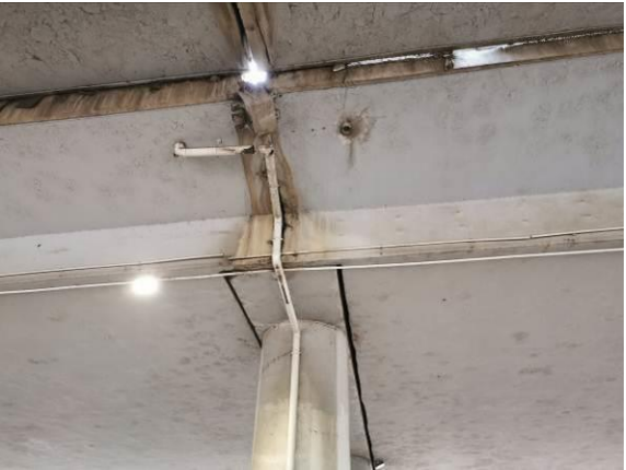
图3.1.1-18 8#墩处左侧泄水管损坏
