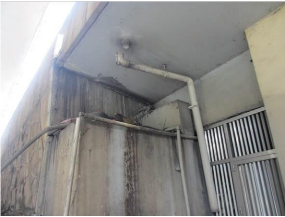
图3.1.1-21 13#桥台处左侧泄水管损坏
