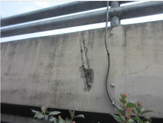
图3.1.4-17 左侧护栏 10#跨处外侧混凝土剥落、露筋，面积约 0.04 m²
