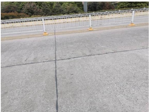
图 3.1.1-8 5#跨桥面局部轻微露骨, 面积约 10 m²
