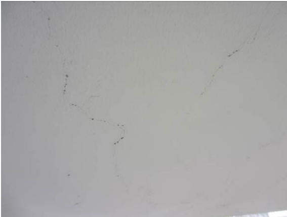
图3.1.11-13 22#跨梁体底板横向贯通裂缝，缝宽 0.20\text{mm}
