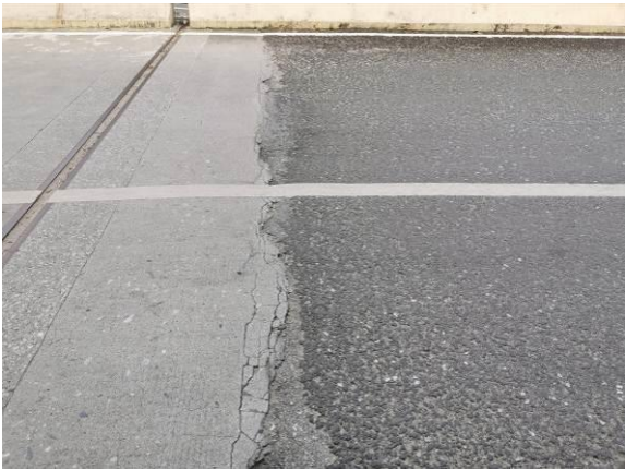
图3.1.16-6 0#伸缩缝与桥面高差明显
