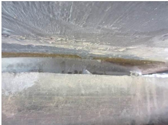
图 3.1.12-11 27-1#支座开裂、钢板锈蚀
