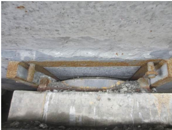
图3.2.2-6 Y-3-2 支座钢板锈蚀
