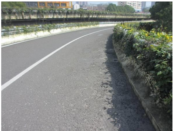
图 3.1.7-13 6#、7#、8#桥面铺装局部坑槽，面积约 5.0 m²
