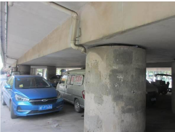
图3.1.4-20 1#墩处泄水管破损
