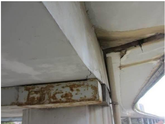
图3.1.11-10 22#跨梁体 21#墩处左侧腹板破损，面积 1.65 \times 0.85 \text{ m}^2
