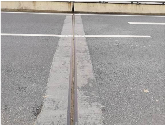
图 3.1.2-14 5#伸缩缝堵塞，伸缩缝宽度 4.2cm
