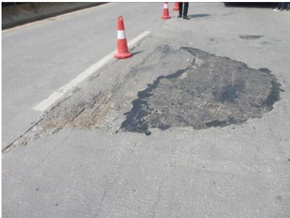
图3.1.10-7 21#右侧桥面破损、钢筋裸露
