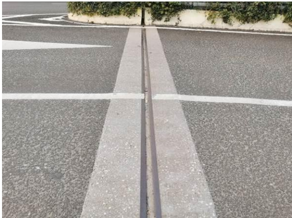
图3.1.15-6 0#伸缩缝堵塞，伸缩缝宽度 5.0cm
