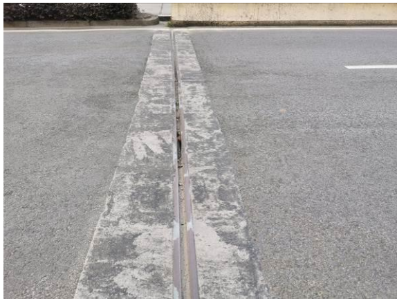
图3.1.3-15 0#伸缩缝堵塞、止水带破损，伸缩缝宽度 3.5cm
