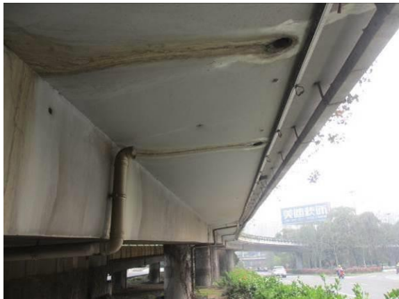
图 3.1.14-20 10#墩处泄水管破损
