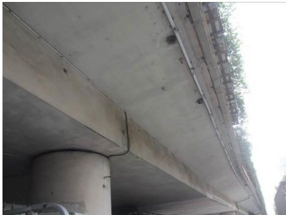
图 3.1.4-22 5#墩处泄水管缺失
