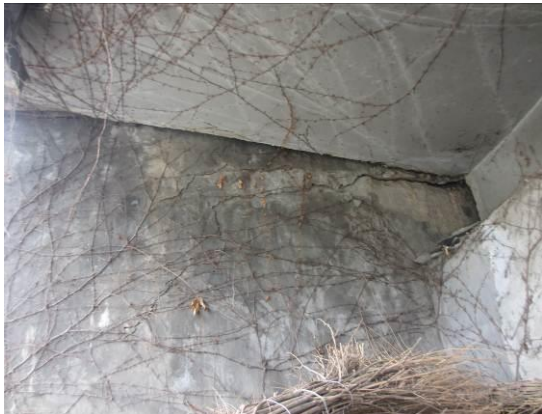
图 3.1.12-10 28#桥台左侧背墙混凝土破损、植被
