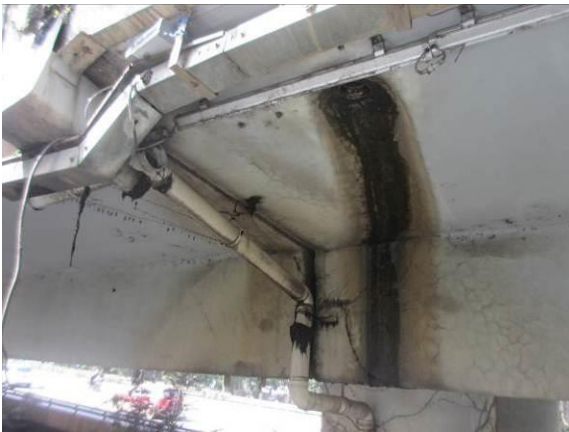
图 3.1.5-43 10#墩处泄水管部分缺失
