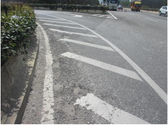
图3.1.5-34 18#桥面铺装局部坑槽，面积约 2.4 m 2
