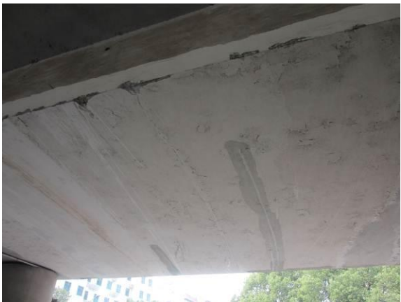
图 3.1.4-6 5#梁体底部刮痕
