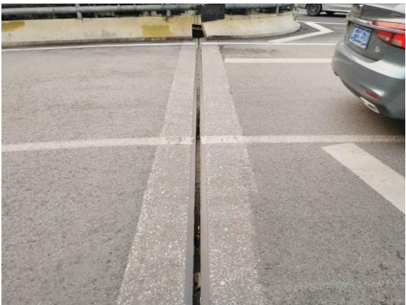
图 3.1.8-12 4#伸缩缝堵塞、止水带破损，伸缩缝宽度 3.8cm
