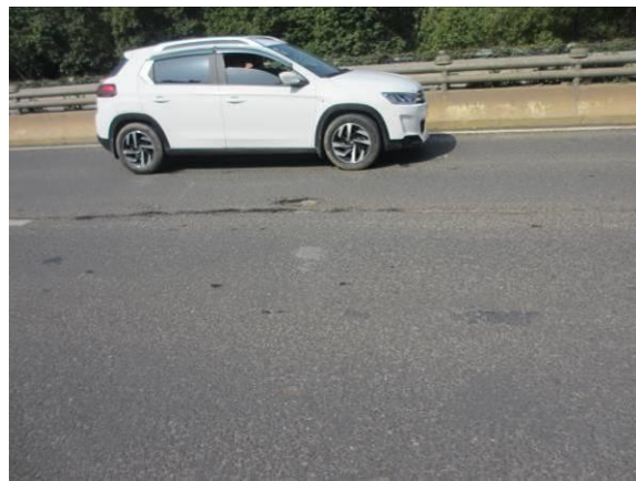
图3.1.5-24 3#桥面铺装局部坑槽，面积约 1.0 m 2
