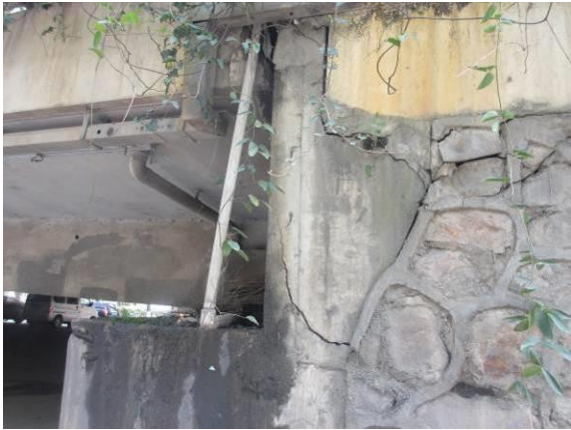
图 3.1.4-8 0#台帽左侧侧墙破损
