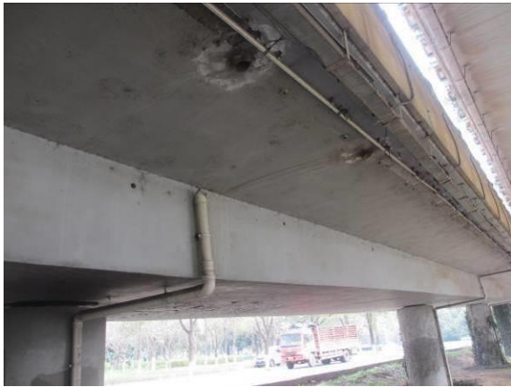
图 3. 1. 11-22 28#墩处泄水管破损
