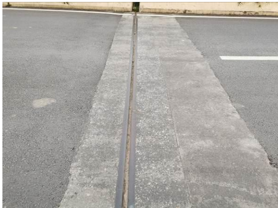
图 3.1.14-17 11#伸缩缝堵塞，伸缩缝宽度 3.0cm，伸缩缝与路面连接处有高差
