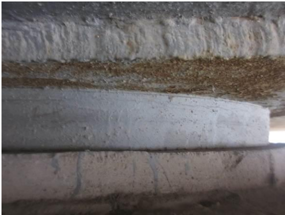
图 3.1.9-5 2#支座开裂、钢板锈蚀
