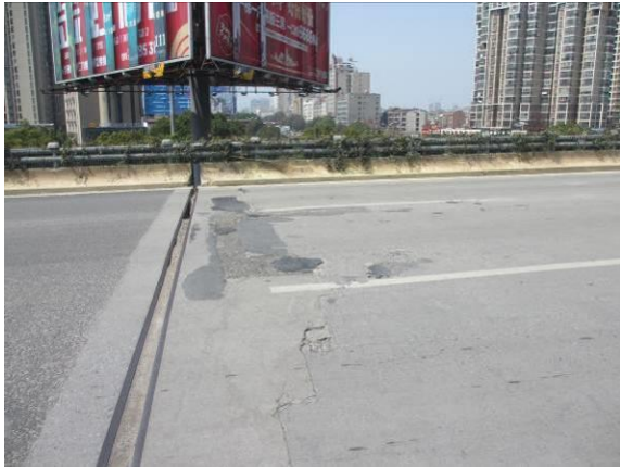
图3.1.10-5 19#桥面伸缩缝处坑洞，面积约 0.6 m²
