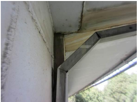
图3.1.11-8 22#跨梁体 21#墩处横向偏位，距离约 9.5\text{cm}
