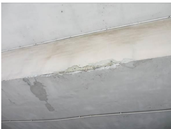
图 3.1.4-7 6#梁体左侧局部破损，面积约 0.2 m²
