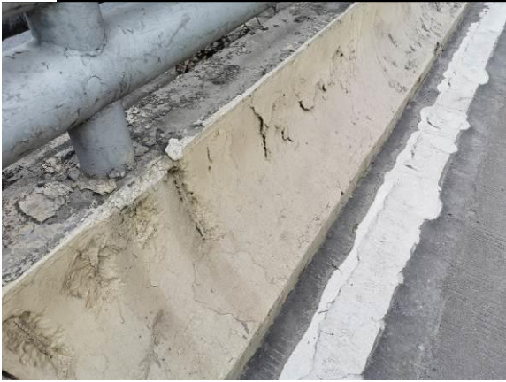
图3.1.1-14 Z-护栏多处混凝土剥落、露筋，面积约 5.0 m²
