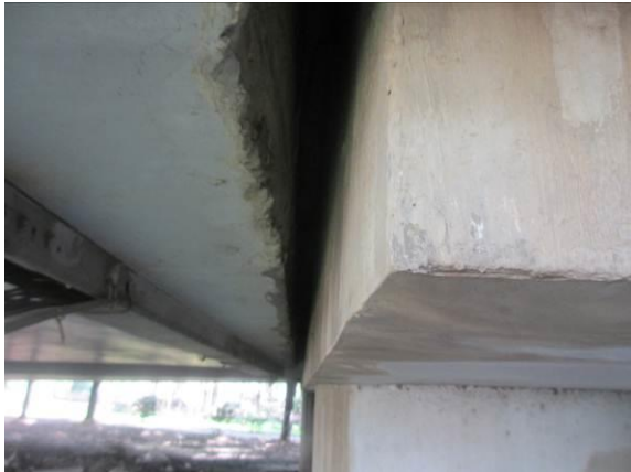
图 3.1.14-6 1#跨梁体底板距桥墩 9.0cm
