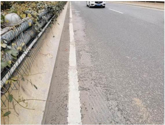
图 3.1.4-12 4#桥面铺装局部坑槽，面积约 4.2 m²
