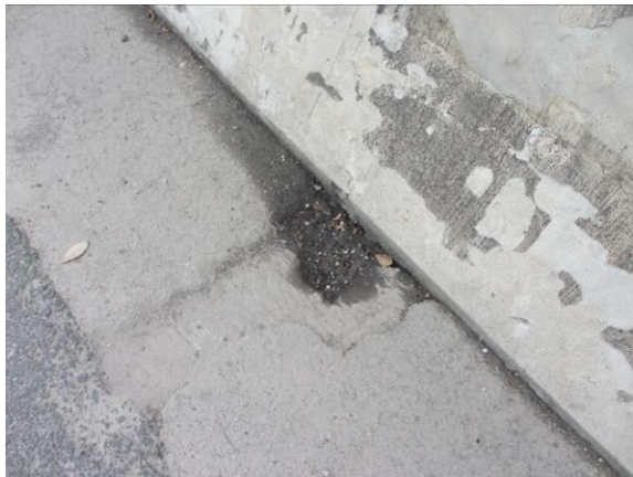
图 3.2.2-10 桥面较多泄水孔堵塞
