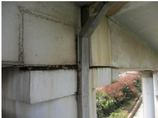
图3.1.11-9 22#跨梁体 21#墩处横向偏位，距离约 9.5\text{cm}
