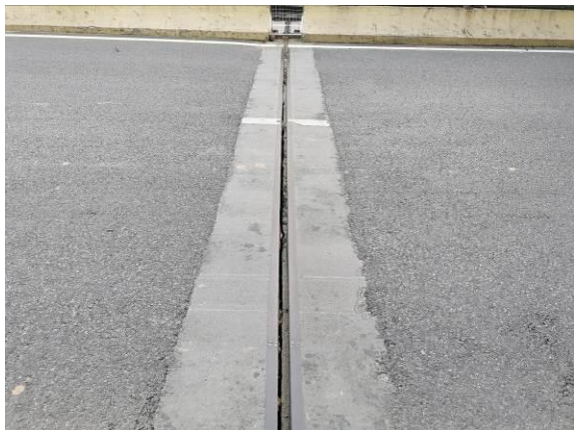
图 3.1.2-15 8#伸缩缝止水带破损，伸缩缝宽度 4.7cm
