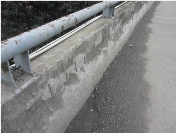
图3.2.1-6 Z-护栏多处混凝土剥落、露筋，面积约 1.0 m²，护栏高 0.50m（混凝土）+0.42m（钢扶手），总高度小于 1.10m，混凝土护栏高度小于 0.70m
