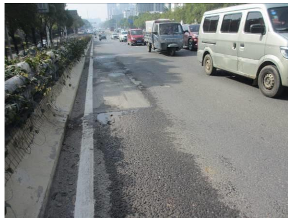
图3.1.5-23 1#桥面铺装局部坑槽，面积约 0.8 m 2
