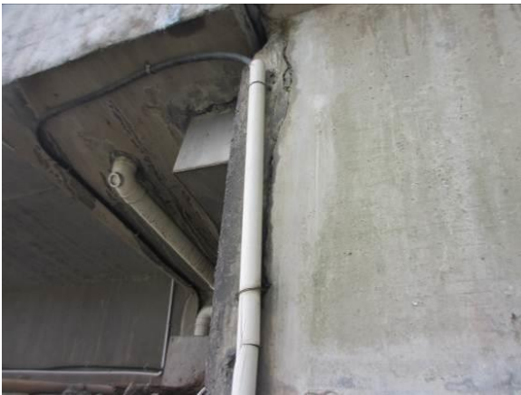
图3.2.2-4 Y-3#桥台前墙局部破损
