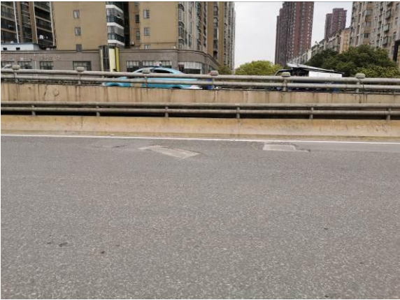
图 3.1.4-13 5#桥面铺装局部坑槽，面积约 1.2 m²
