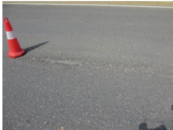
图3.1.5-26 5#桥面铺装局部坑槽，面积约 0.3 m 2
