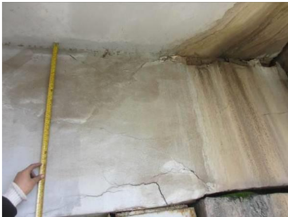
图3.1.11-5 22#跨梁体 21#墩处左侧腹板破损，面积 1.65 \times 0.85 \text{ m}^2 ，钢筋锈蚀
