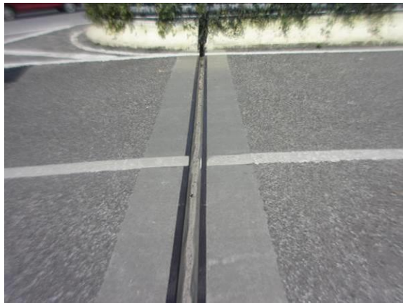
图3.1.7-15 1#伸缩缝结构缝宽异常，伸缩缝宽度 8.9cm
