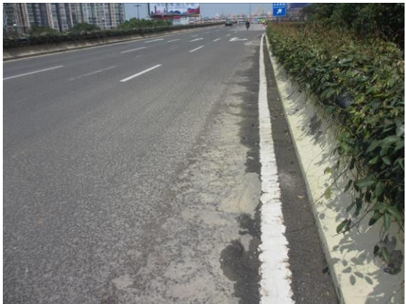
图3.1.5-31 11#、12#桥面铺装局部坑槽，面积约 3.2 m 2
