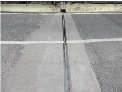
图 3.1.9-8 4#伸缩缝堵塞、止水带破损， 伸缩缝宽度 3.7cm
