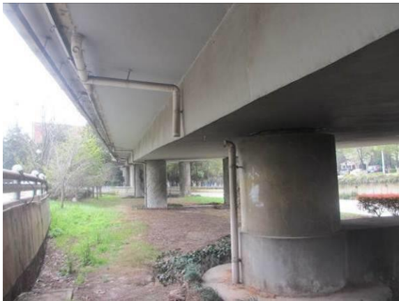
图3.1.12-17 27#墩处右侧泄水管破损
