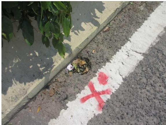
图3.1.12-16 桥面较多泄水孔堵塞
