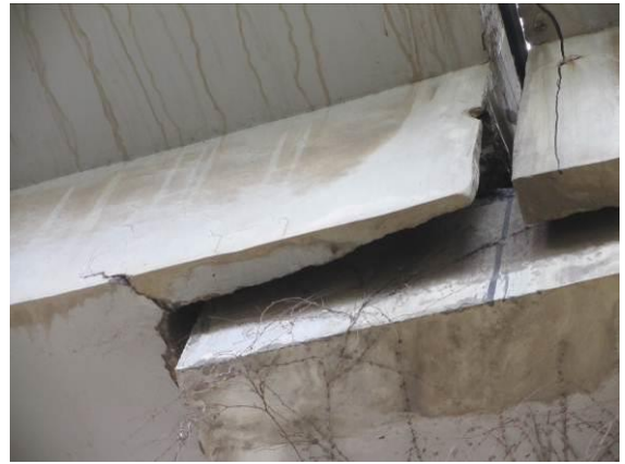
图 3.1.14-7 7#跨梁体 7#墩处右侧腹板破损开裂
