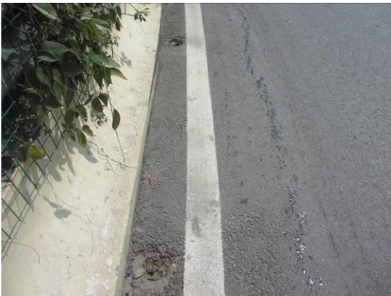
图 3.1.6-11 桥面较多泄水孔堵塞
