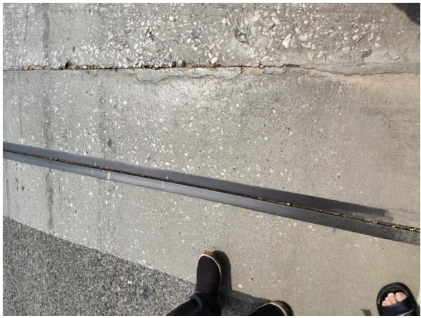
图 3.3.1-4 桥台处伸缩缝卡死
