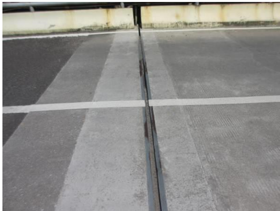
图3.1.7-16 9#伸缩缝堵塞、止水带破损，伸缩缝宽度 4.0cm
