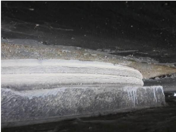
图 3.1.9-6 3#支座开裂、钢板锈蚀
