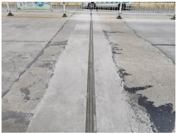
图3.1.1-13 13#伸缩缝堵塞，伸缩缝宽 4.2cm
