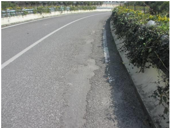
图 3.1.7-11 1#、2#桥面铺装局部坑槽，面积约 3.5 m²
