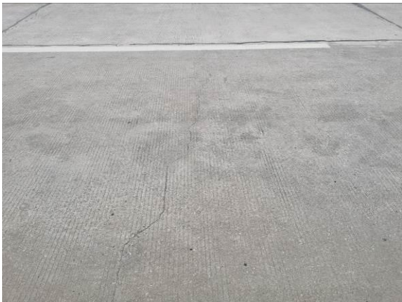
图 3.1.1-9 10#跨桥面横向裂缝, L=4.0m
