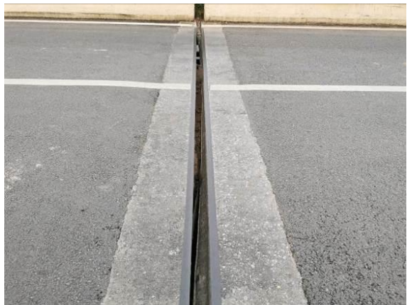
图 3.1.14-16 7#伸缩缝止水带破损，结构缝宽异常，伸缩缝宽度 8.7cm
