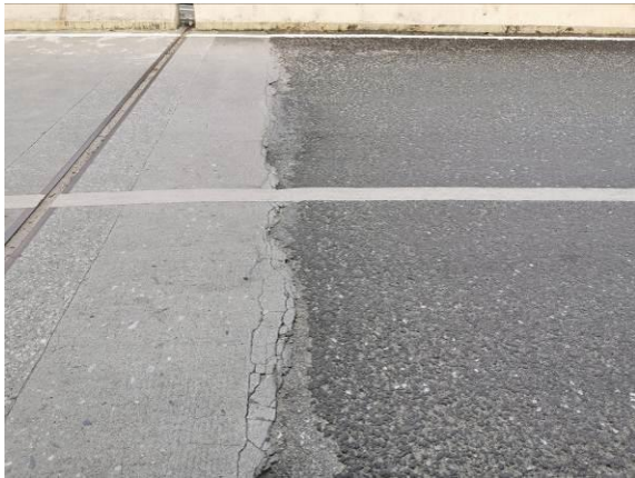
图3.1.16-5 1#桥面铺装局部坑槽，面积约 0.05 m²
