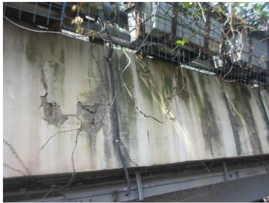
图3.1.12-15 护栏外侧混凝土局部剥落、露筋，面积约 5.0 m²
