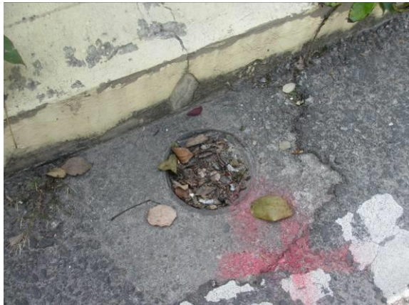
图 3.1.9-9 桥面较多泄水孔堵塞
