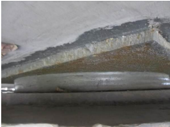
图 3.1.2-9 2#支座开裂、钢板锈蚀
