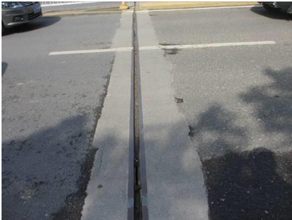
图 3.1.5-35 0#伸缩缝堵塞、止水带破损，伸缩缝宽度 3.5cm
