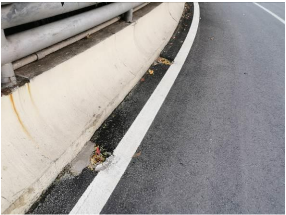
图3.1.13-7 桥面较多泄水孔堵塞
