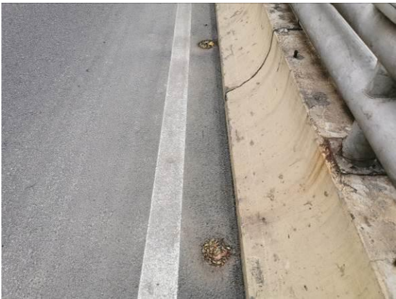
图 3.1.2-17 桥面较多泄水孔堵塞
