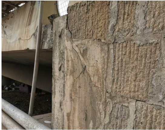
图3.1.2-8 17#桥台右侧混凝土局部破损
