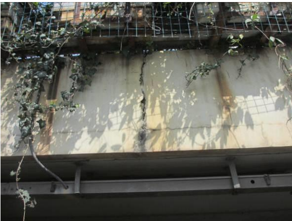
图3.1.3-19 右侧护栏多处混凝土剥落、露筋，面积约 6.0 m²
