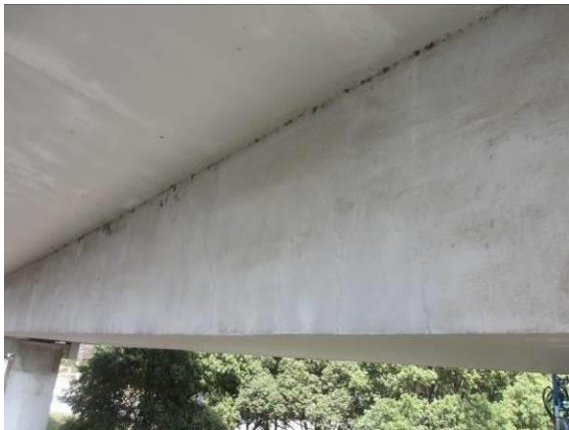
图3.1.11-12 22#跨梁体腹板竖向裂缝，缝宽 0.18\text{mm}
