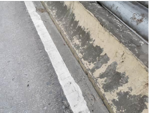
图3.1.1-16 桥面较多泄水孔堵塞
