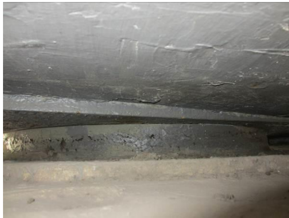
图 3.1.14-14 10#支座开裂、钢板锈蚀
