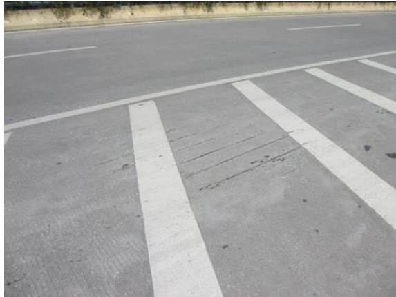
图3.1.10-6 20#、21#桥面右侧破损、钢筋裸露
