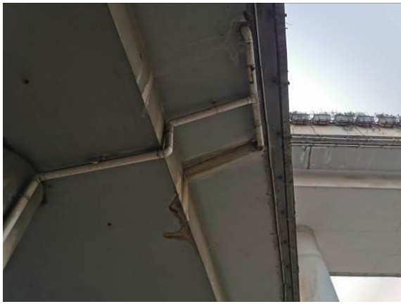
图 3.1.2-18 7#墩处左侧泄水孔损坏
