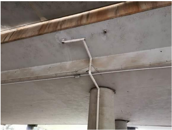
图3.1.1-19 9#墩处左侧泄水管损坏
