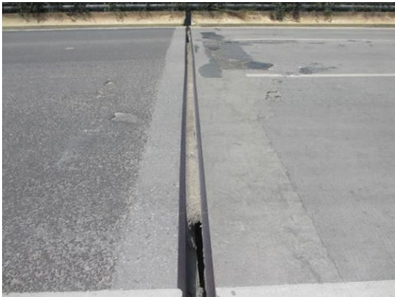
图 3.1.5-37 18#伸缩缝堵塞、止水带破损，伸缩缝宽度 9.8cm
