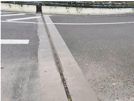
图3.1.15-7 5#伸缩缝堵塞，伸缩缝宽度 5.1cm
