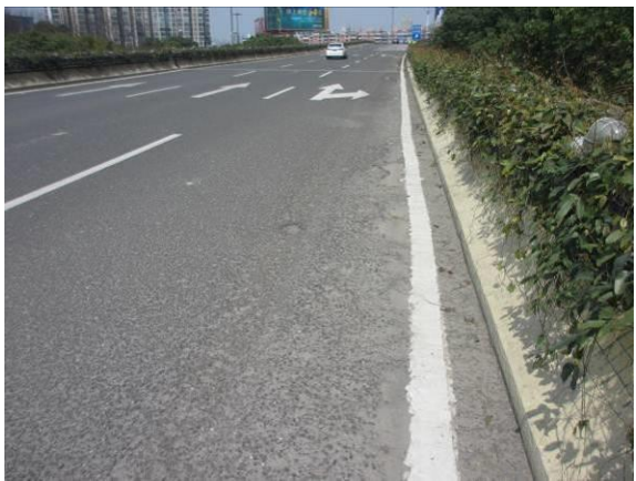
图3.1.5-29 9#桥面铺装局部坑槽，面积约 1.5 m 2
