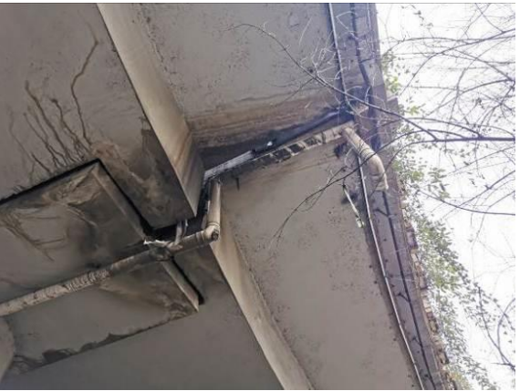
图3.1.3-21 5#墩处右侧泄水管破损
