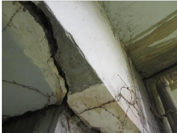
图3.1.3-6 10#跨与 A1 匝道连接处右侧腹板混凝土破损，长高宽（1.35m×0.85m×0.20m）
