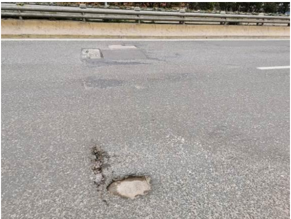
图 3.1.4-10 2#桥面铺装局部松散、坑槽，面积约 2.5 m²
