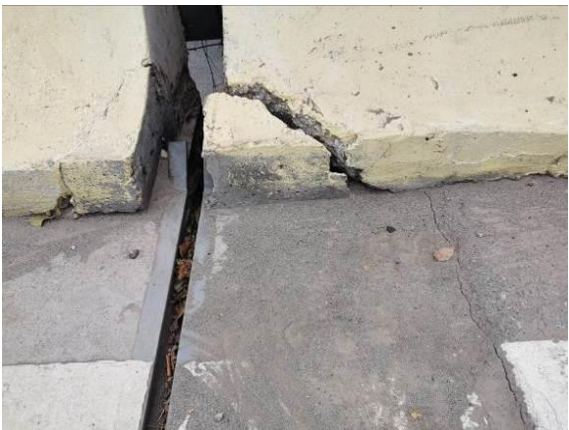
图3.1.4-18 左、右侧护栏 10#伸缩缝处破损
