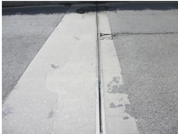
图3.1.11-21 29#伸缩缝堵塞、止水带破损、锚固区破损，伸缩缝宽度 2.8cm，伸缩缝与路面连接处有高差
