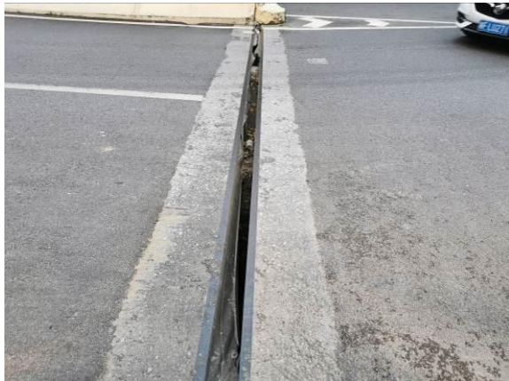
图 3.1.14-15 0#伸缩缝止水带破损，结构缝宽异常，伸缩缝宽度 11.3cm
