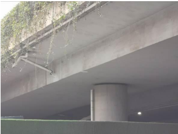
图 3.1.3-22 6#墩处右侧泄水管破损
