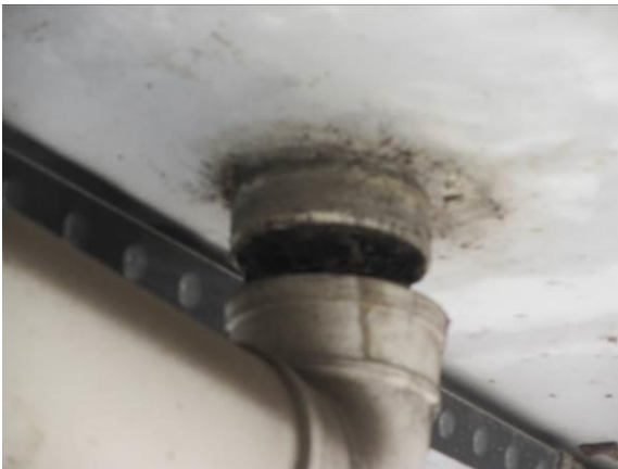
图 3.1.5-41 5#墩处泄水管部分脱落
