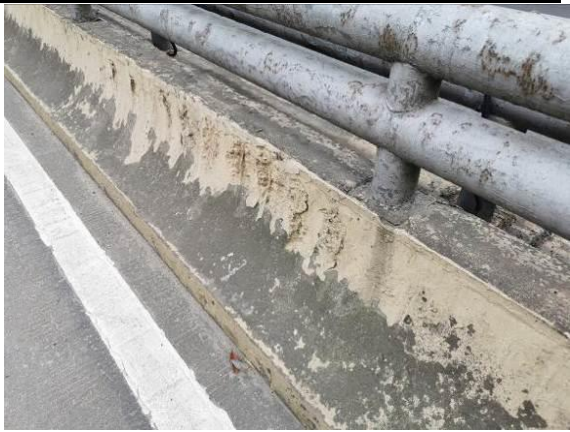
图3.1.1-15 Y-护栏多处混凝土剥落、露筋，面积约 5.0 m²
