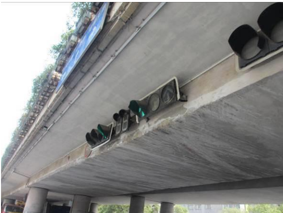
图 3.1.4-4 4#梁体左侧因车辆撞击破损，梁底刮痕
