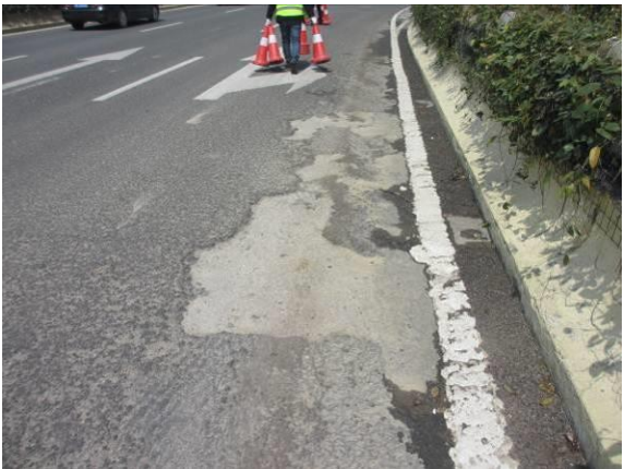
图3.1.5-32 13#桥面铺装局部坑槽，面积约 5.0 m 2
