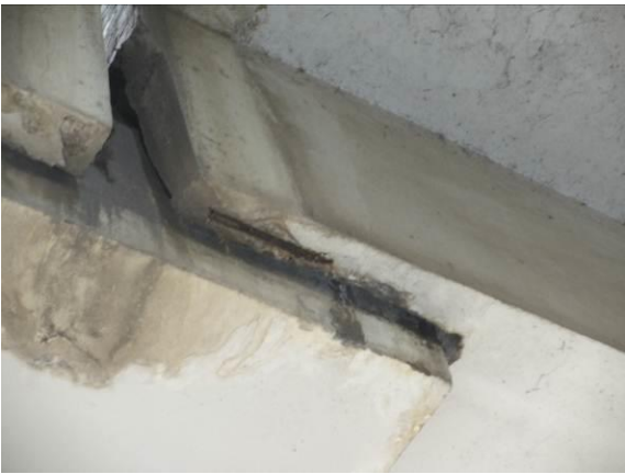
图 3.1.3-4 8#跨梁体左侧腹板 8#墩处剥落、露筋，面积约 0.03\text{ m}^2
