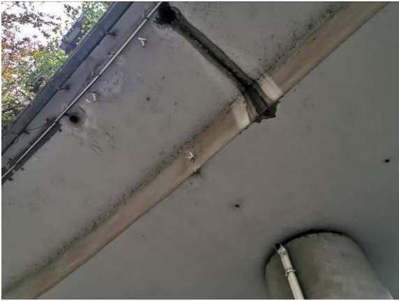
图 3.1.2-19 10#墩处左侧泄水孔损坏
