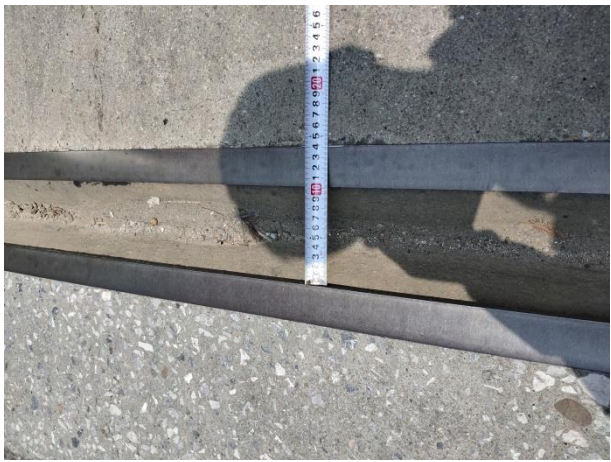
图 3.3.1-2 21#伸缩缝宽度
