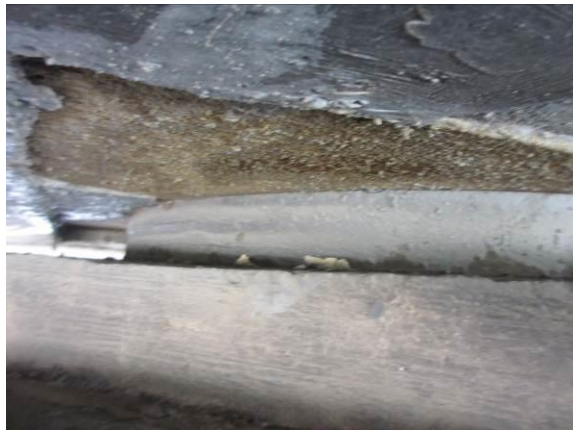
图 3.1.12-12 27-2#支座开裂、钢板锈蚀
