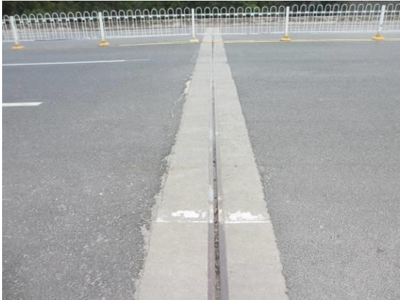
图 3.2.1-4 Z-0#伸缩缝堵塞，伸缩缝宽 2.5cm
