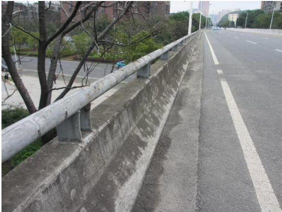
图3.2.2-9 Y 护栏多处混凝土剥落、露筋，面积约 1.0 m²，护栏高 0.50m（混凝土）+0.42m（钢扶手），小于 1.10m
