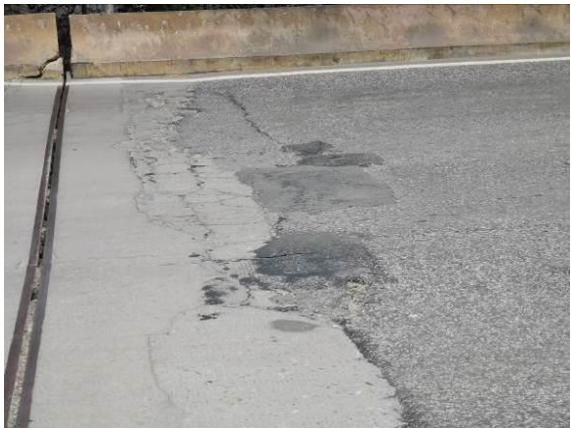
图3.1.4-14 10#桥面铺装局部坑槽，面积约 0.1 m²
