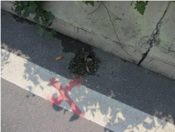
图3.1.16-9 桥面大部分泄水孔堵塞
