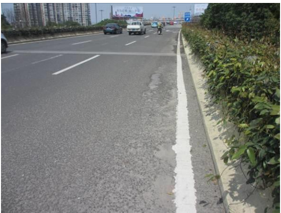
图3.1.5-30 10#桥面铺装局部坑槽，面积约 1.2 m 2
