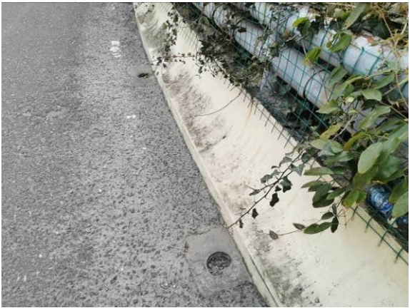
图3.1.15-8 桥面较多泄水孔堵塞
