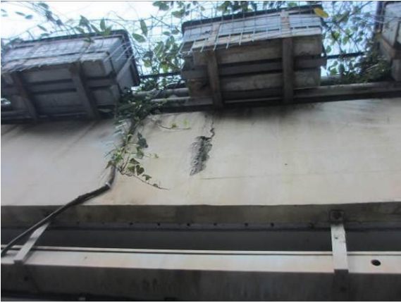
图 3.1.5-38 右侧护栏多处混凝土剥落、露筋，面积约 5 m²
