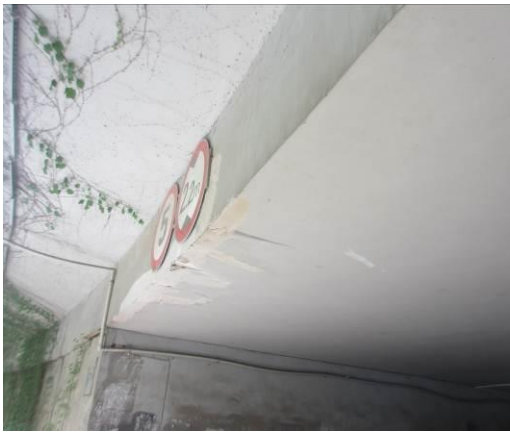
图 3.1.3-3 2#跨梁底右侧刮痕
