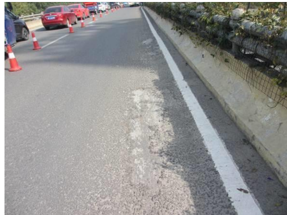
图3.1.5-25 4#桥面铺装局部坑槽，面积约 2.2 m 2
