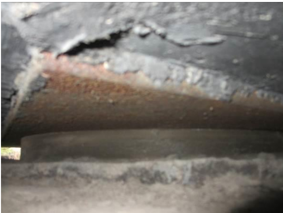
图 3. 1. 8-8 1#支座开裂、钢板锈蚀
