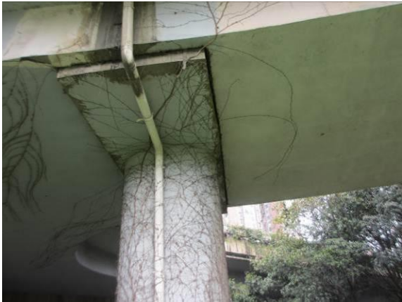
图 3. 1. 6-5 1#桥墩植被，被水污染
