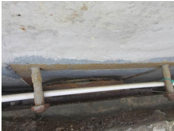
图 3.2.1-3 Z-3-2#支座钢垫板锈蚀
