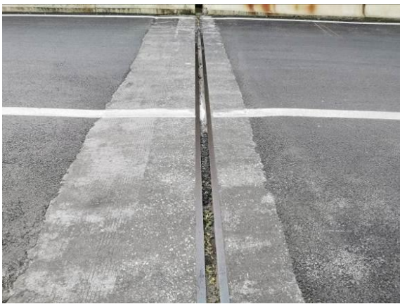
图3.1.13-6 2#伸缩缝堵塞，结构缝宽异常，伸缩缝宽度 5.9cm
