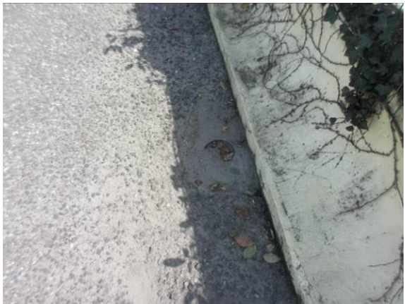
图3.1.7-17 桥面较多泄水孔堵塞
