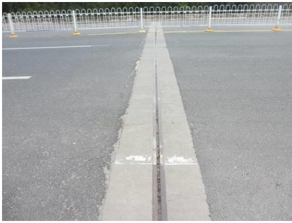
图3.2.2-7 Y-0#伸缩缝堵塞，伸缩缝宽度 2.4cm
