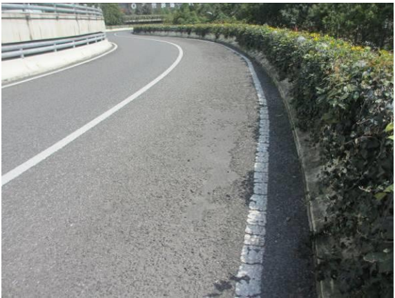
图 3.1.7-12 3#、4#、5#桥面铺装局部坑槽，面积约 4.0 m²
