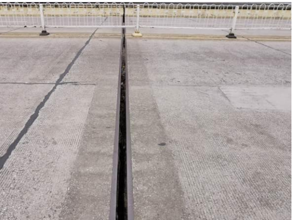
图 3.1.1-11 5#伸缩缝止水带破损, 结构缝宽异常伸缩缝宽 7.7cm
