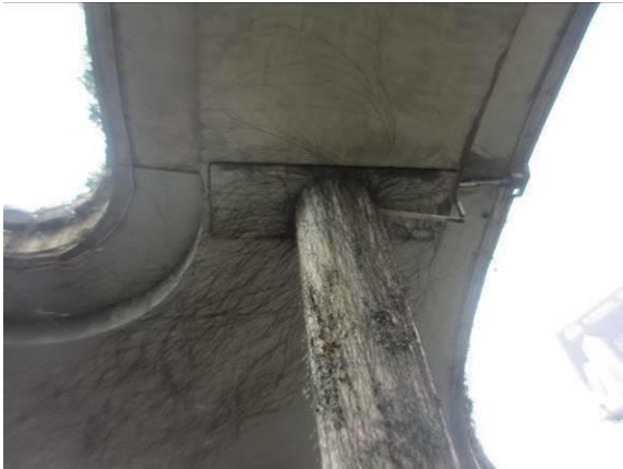
图 3.1.6-7 8#桥墩植被，被水污染
