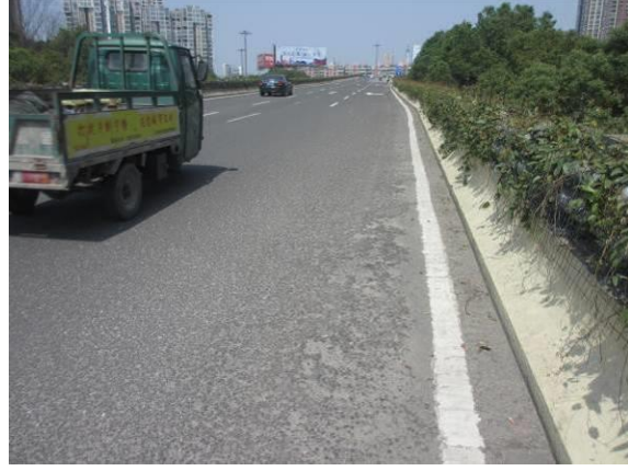
图3.1.5-28 7#、8#桥面铺装局部坑槽，面积约 1.8 m 2
