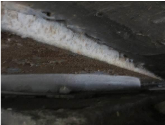
图 3. 1. 8-9 2#支座开裂、钢板锈蚀
