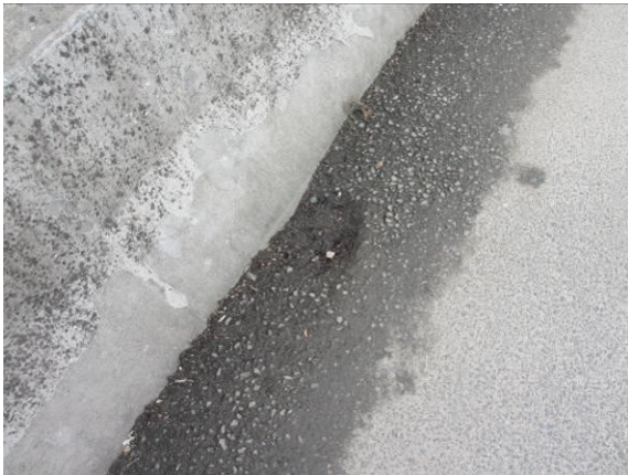
图 3.2.1-7 桥面较多泄水孔堵塞
