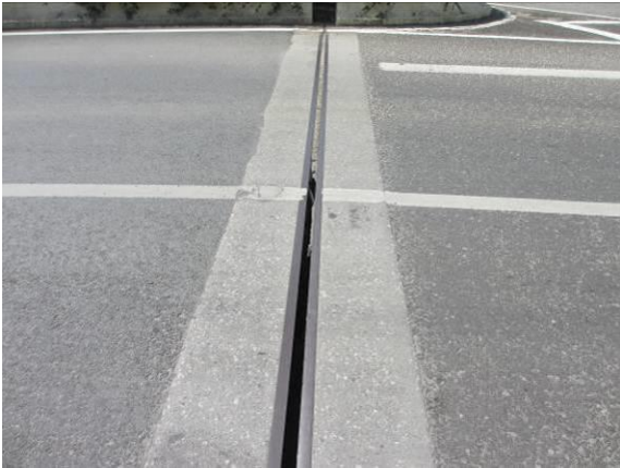
图 3.1.6-9 8#伸缩缝堵塞、止水带破损，伸缩缝宽度 4.0cm
