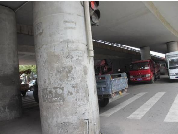
图 3.1.5-40 4#墩处泄水管部分缺失
