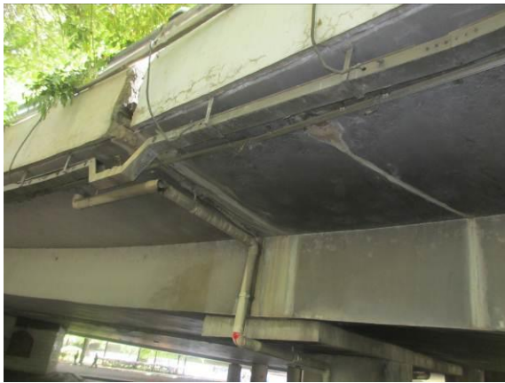
图3.1.13-8 0#墩处右侧泄水管破损
