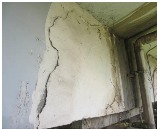
图3.1.3-5 10#跨与 A1 匝道连接处右侧腹板混凝土破损，长高宽（1.35m×0.85m×0.20m）
