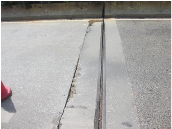
图3.1.11-20 21#伸缩缝堵塞、锚固区破损，伸缩缝宽度 3.4cm
