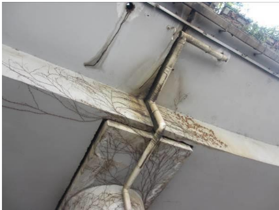
图 3.1.14-19 7#墩处泄水管破损
