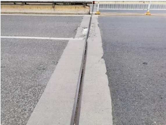
图3.1.4-15 0#伸缩缝堵塞，伸缩缝宽度 2.1cm 锚固区混凝土破损，面积约 0.4 m² 伸缩缝与路面连接处有高差
