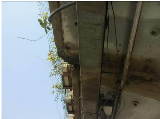
图3.1.11-7 22#跨梁体 21#墩处横向偏位，距离约 9.5\text{cm}
