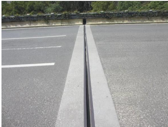
图 3.1.5-36 10#伸缩缝止水带破损，伸缩缝宽度 5.4cm
