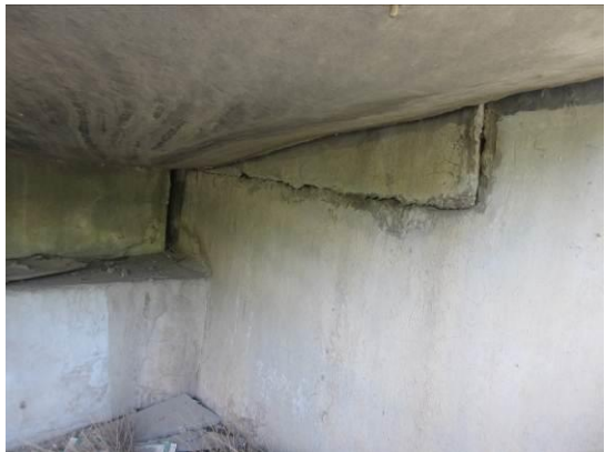
图 3.1.14-12 11#桥台右侧背墙局部破损，面积约 1.0 m²
