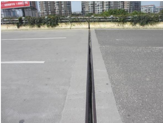
图3.1.12-13 21#伸缩缝止水带破损，结构缝宽异常，伸缩缝宽度 7.2cm
