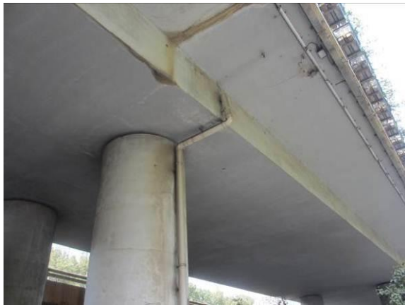
图 3.1.5-42 6#墩处泄水管部分缺失
