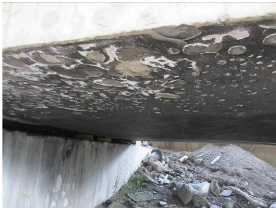
图 3.1.14-9 11#跨涂层脱落，面积约 5 m²
