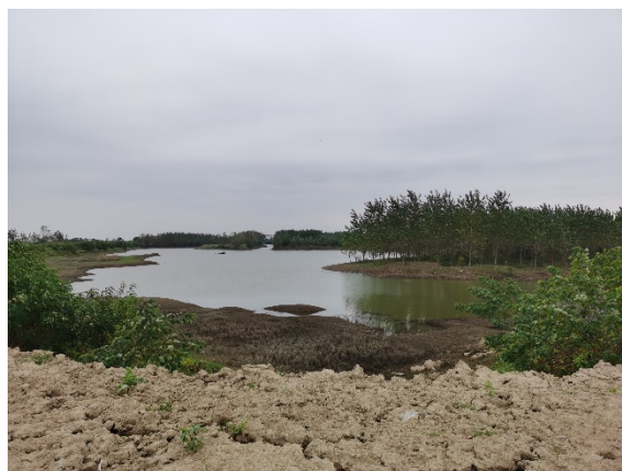
补给水管道沿线
