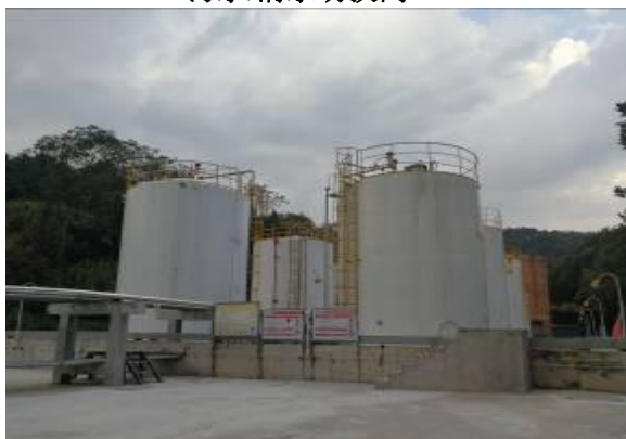
储罐区及围堰
