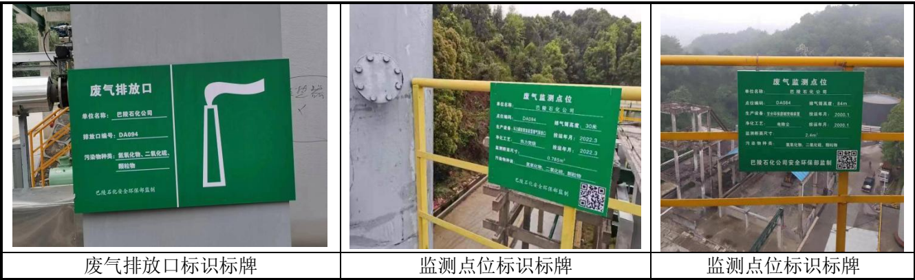
图3.9-1 现有工程排放口现状图
