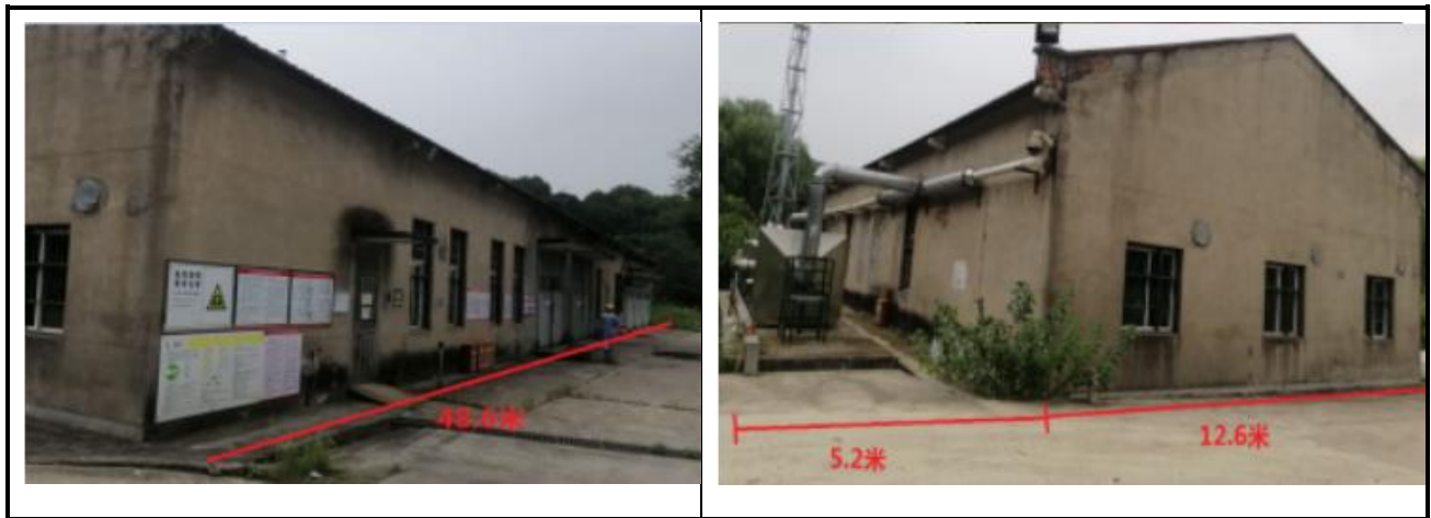
图6.2-17 炼油危险废物暂存间现状图
