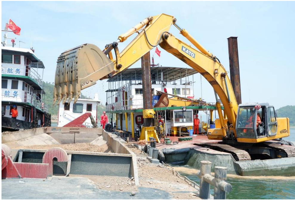
图 3.2-8 反铲挖泥船施工图
