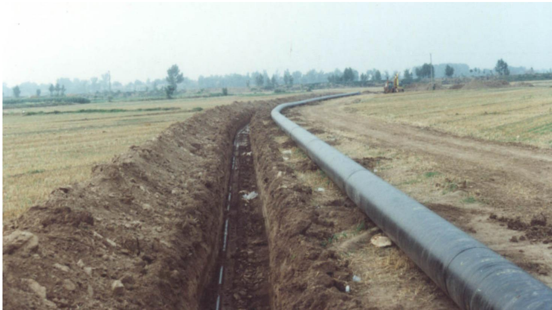
图 3-3 管沟开挖及布管类似实景图
