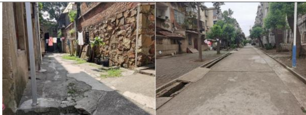
城港老生活区现状
