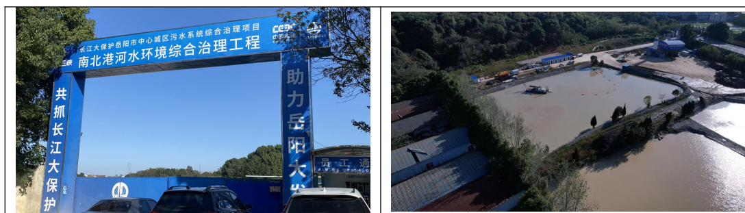
图 5-1 南北港河水环境综合治理工程底泥疏浚工程干化场地现场照片
