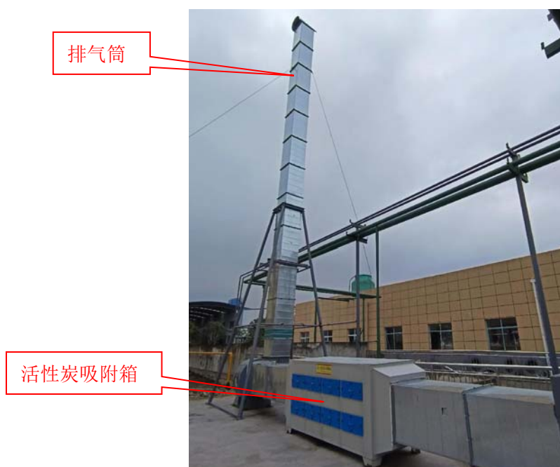
图 7.2-3 现有项目罐区有机废气处理设施图
