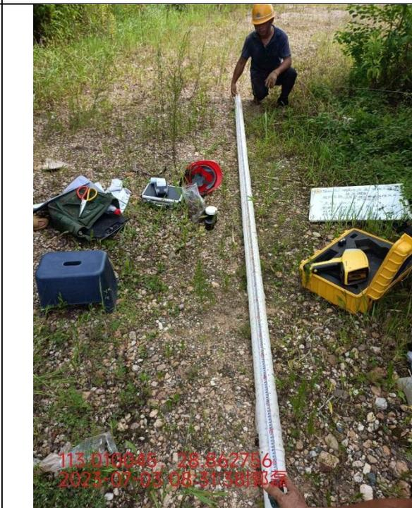
地下水采样井建设--井管连接
