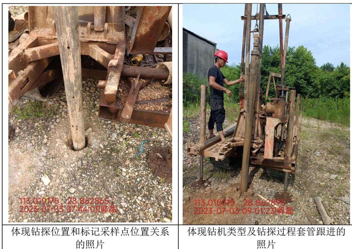
图 5-1 现场钻探照片
