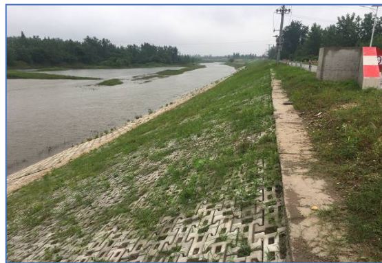
边坡植草砖护坡
