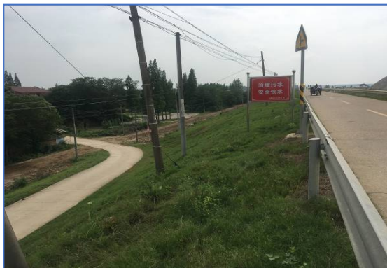
边坡铺草皮护坡
