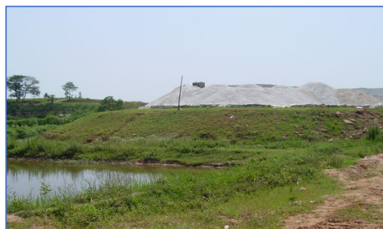
临时覆盖、拦挡
