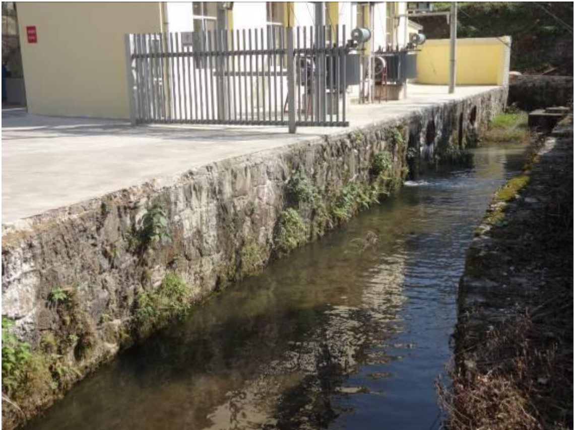
图 15-3 临边部位无安全警示和栏杆
