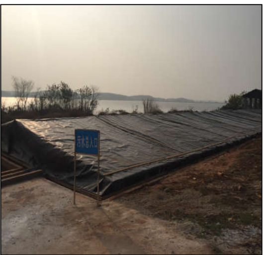
污水预处理池及好氧处理池
