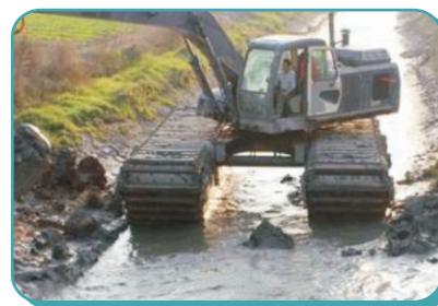
临湘江南镇五级渠疏浚渠道
