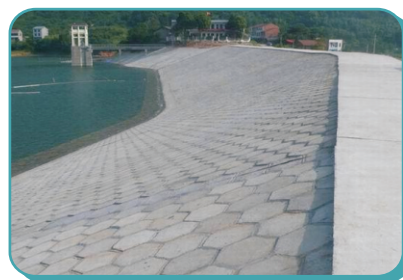
东山水库除险加固
