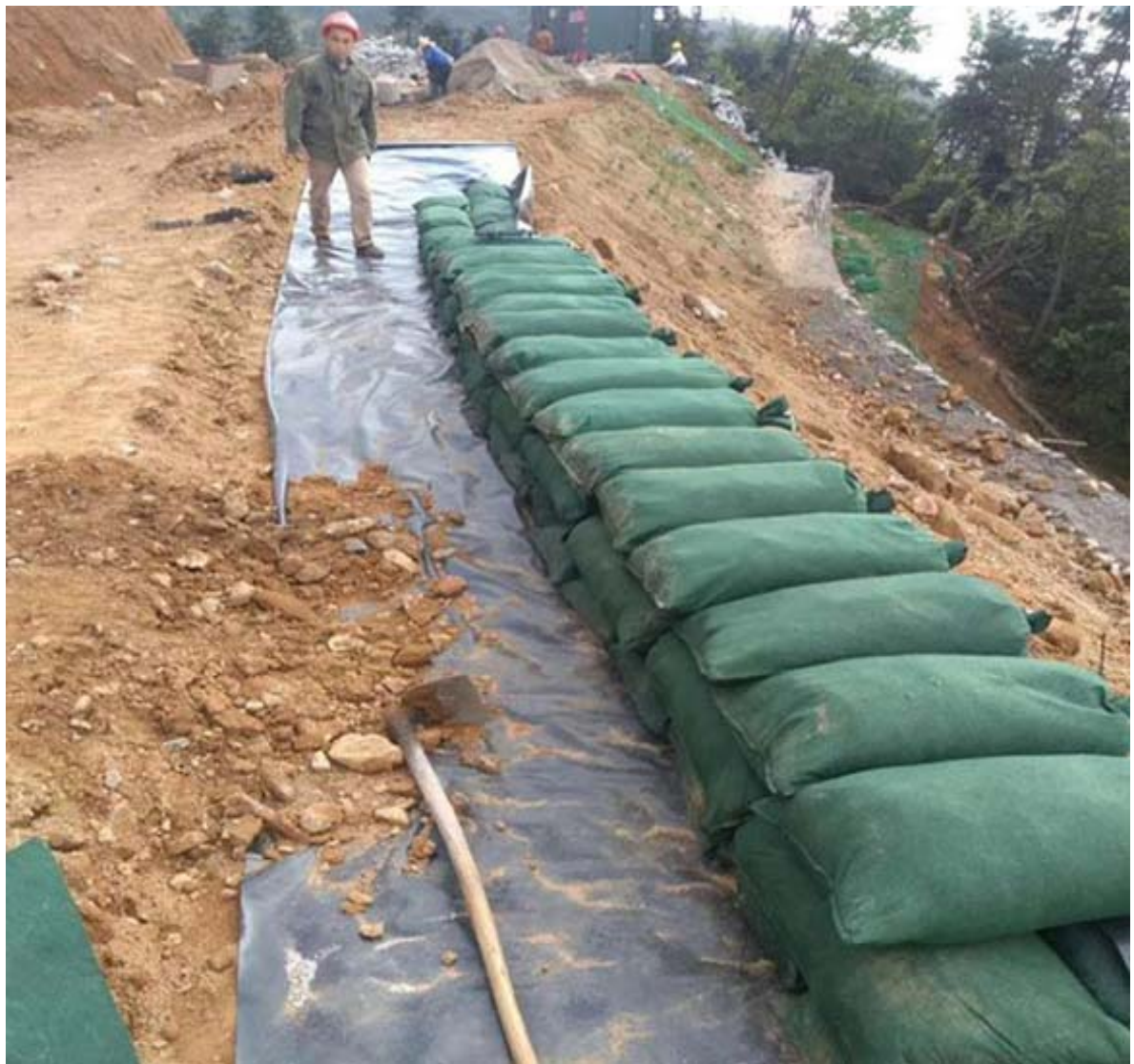
插图 4-3-1 生态袋堆砌示意图
